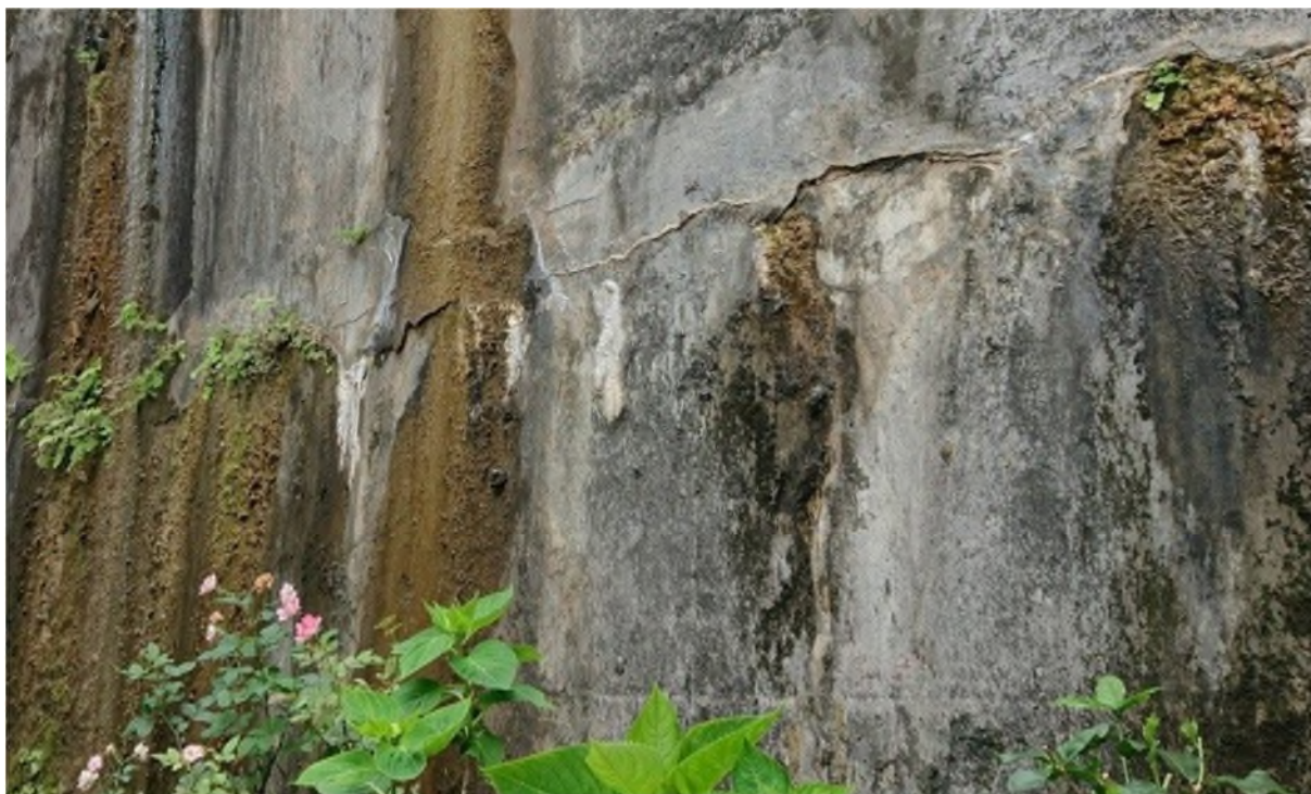
圖 4-25 擋土牆滲水病兆特徵示意圖
