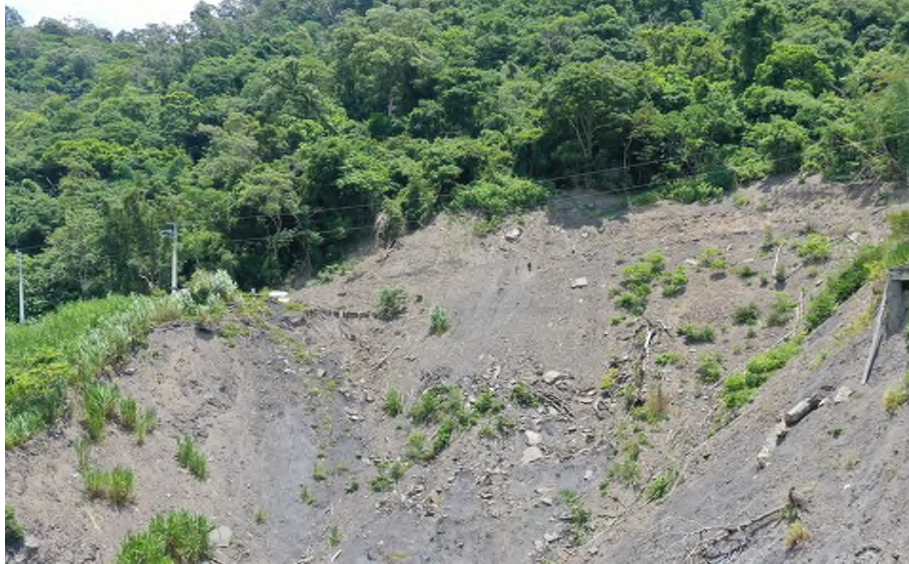
圖 4-12 岩土裸露病兆特徵示意圖
