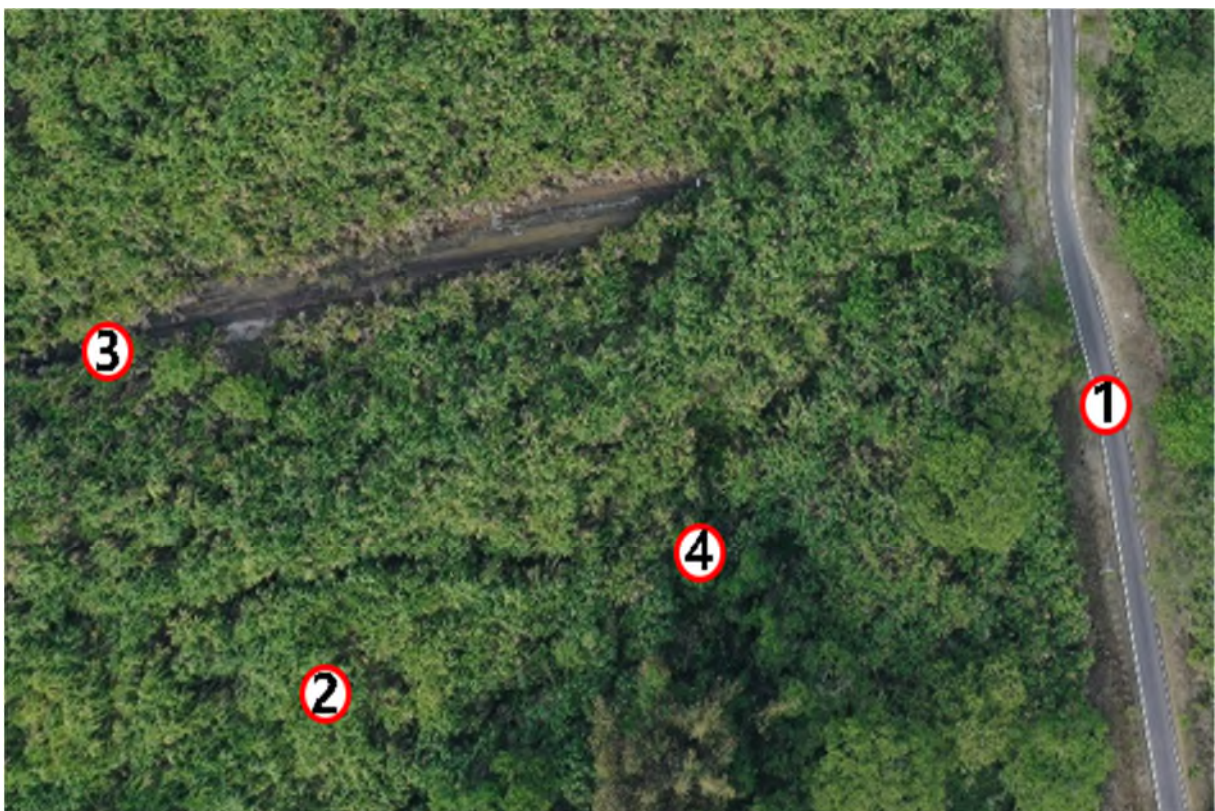
圖 5-26 南投縣國姓鄉邊坡編號 2 全景圖
