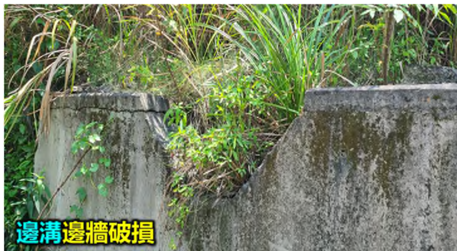
圖 4-21 邊溝邊強破損病兆特徵示意圖
