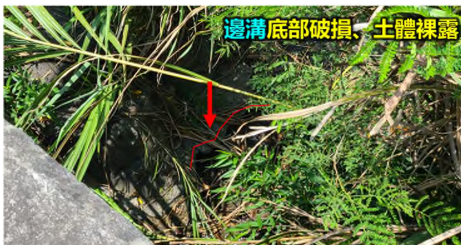
圖 4-22 邊溝底部破損病兆特徵示意圖
