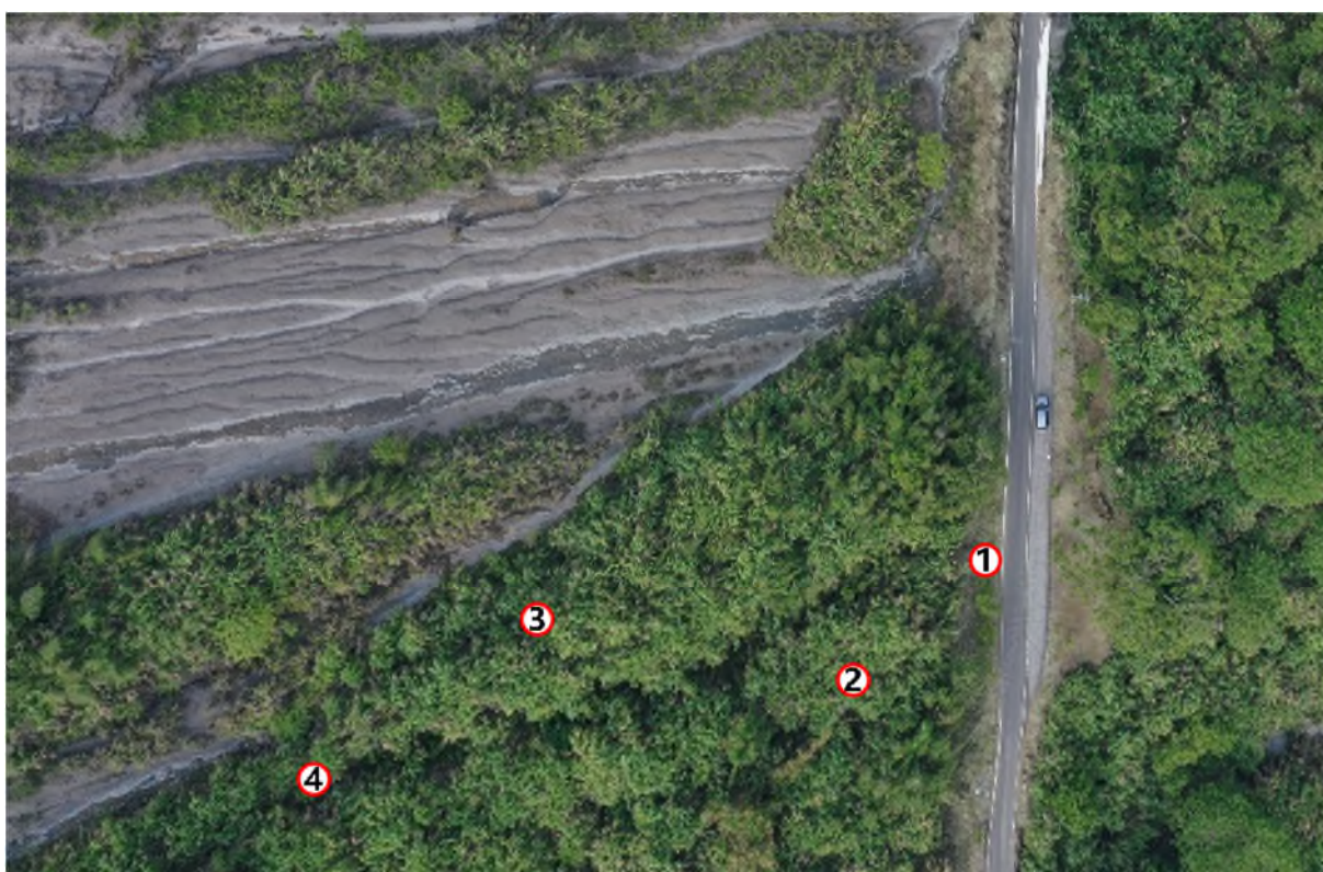
圖 5-28 南投縣國姓鄉邊坡編號 4 全景圖
