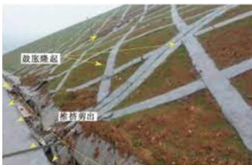
圖 4-15 鼓脹、開裂病兆特徵示意圖
