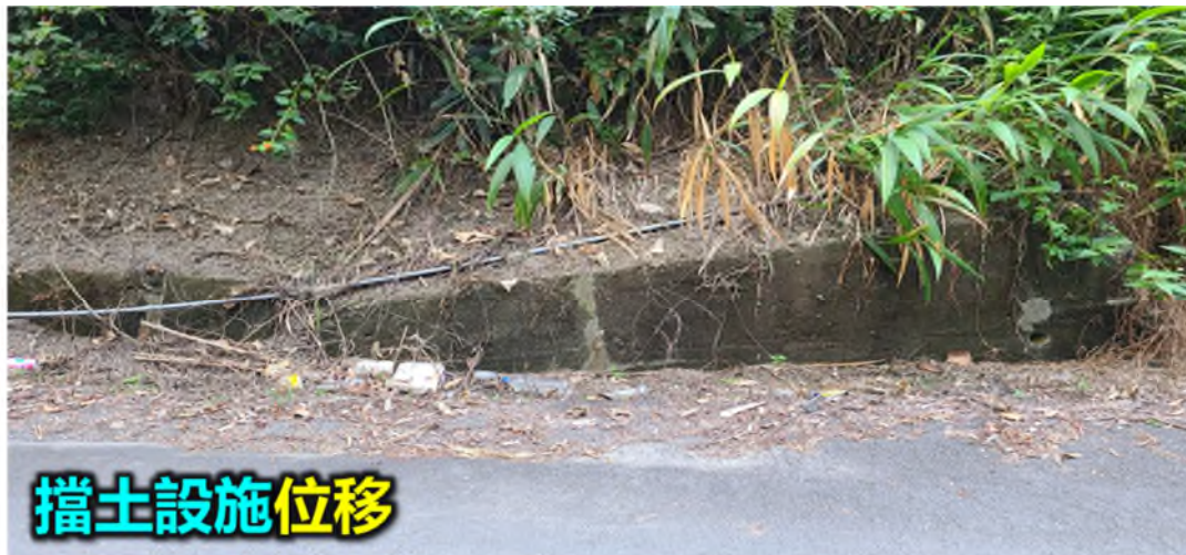
圖 4-27 擋土結構物位移病兆特徵示意圖
