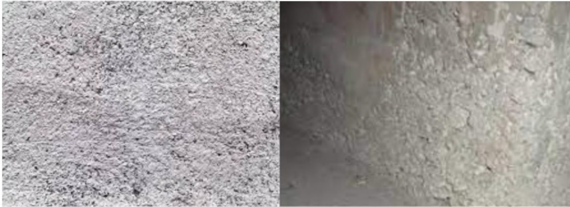
圖 4-23 混凝土表觀風化、脫落病兆特徵示意圖
