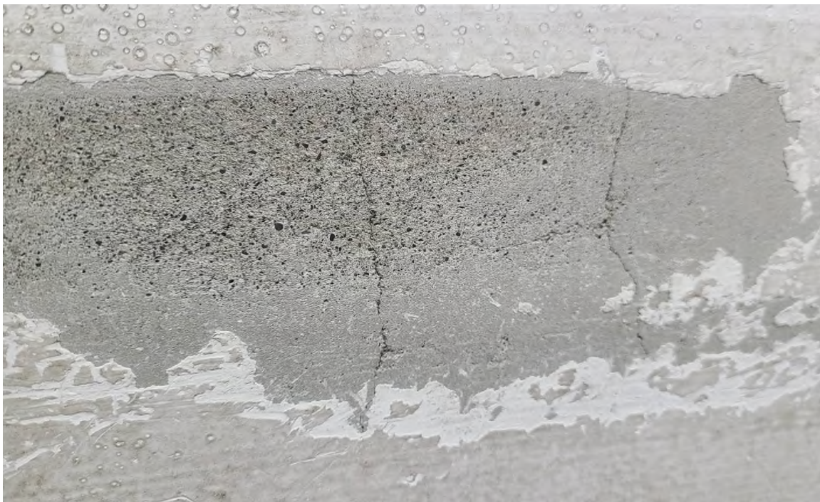
圖 4-24 混凝土表觀細紋、裂縫特徵示意圖
