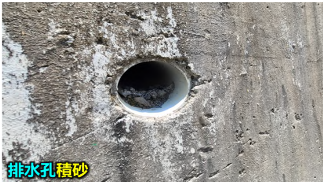
圖 4-20 排水孔積砂病兆特徵示意圖
