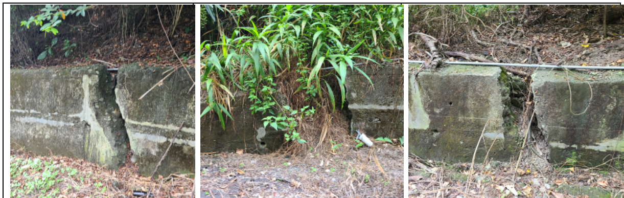
圖 4-28 擋土牆功能缺失特徵示意圖
