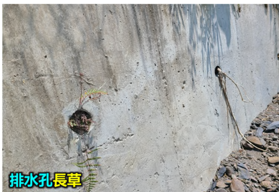
圖 4-18 排水孔長草病兆特徵示意圖
