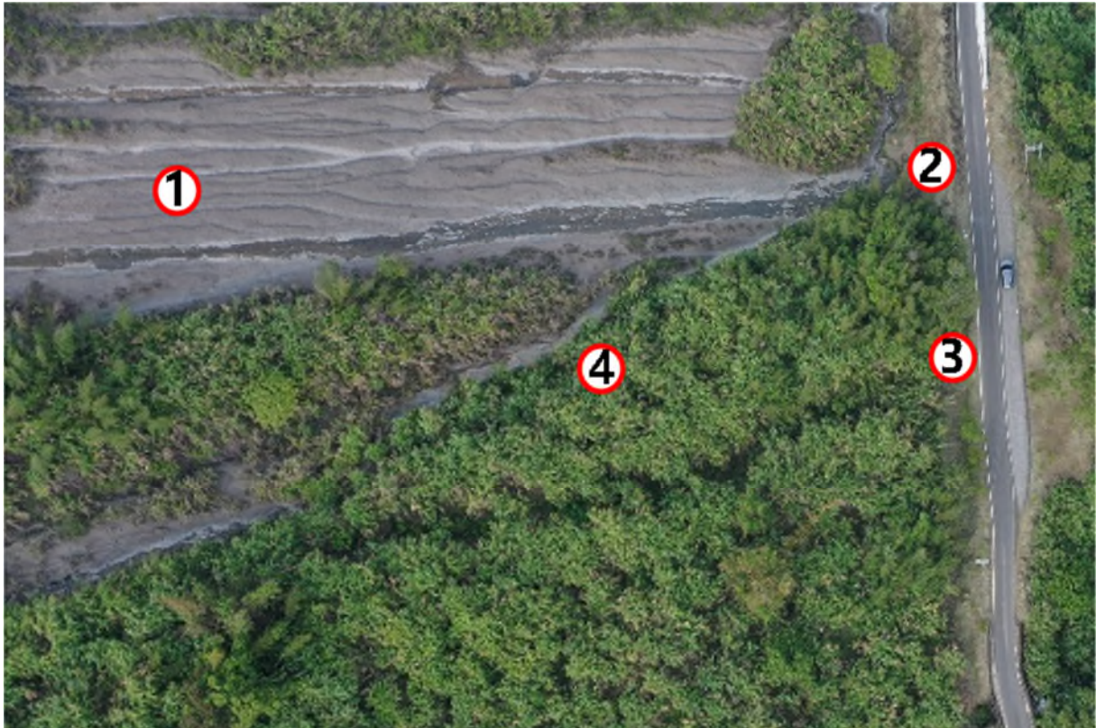
圖 5-25 南投縣國姓鄉邊坡編號 1 全景圖
