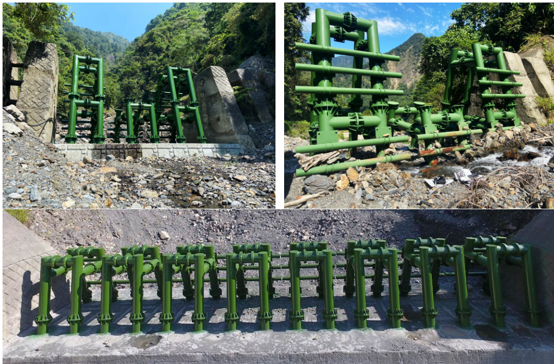
圖 1-1 (左上) 蘭島溪 1 號防砂壩下游側；(右上) 蘭島溪 1 號防砂壩上游側橫材的效果；(下) 蘭島溪 2 號防砂壩 (陳樹群提供)。
