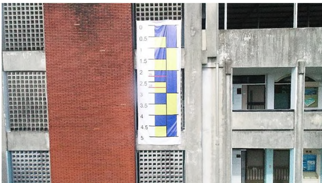
圖 6-3 UAV 距離標尺 10 公尺之標尺(UAV 視角)
