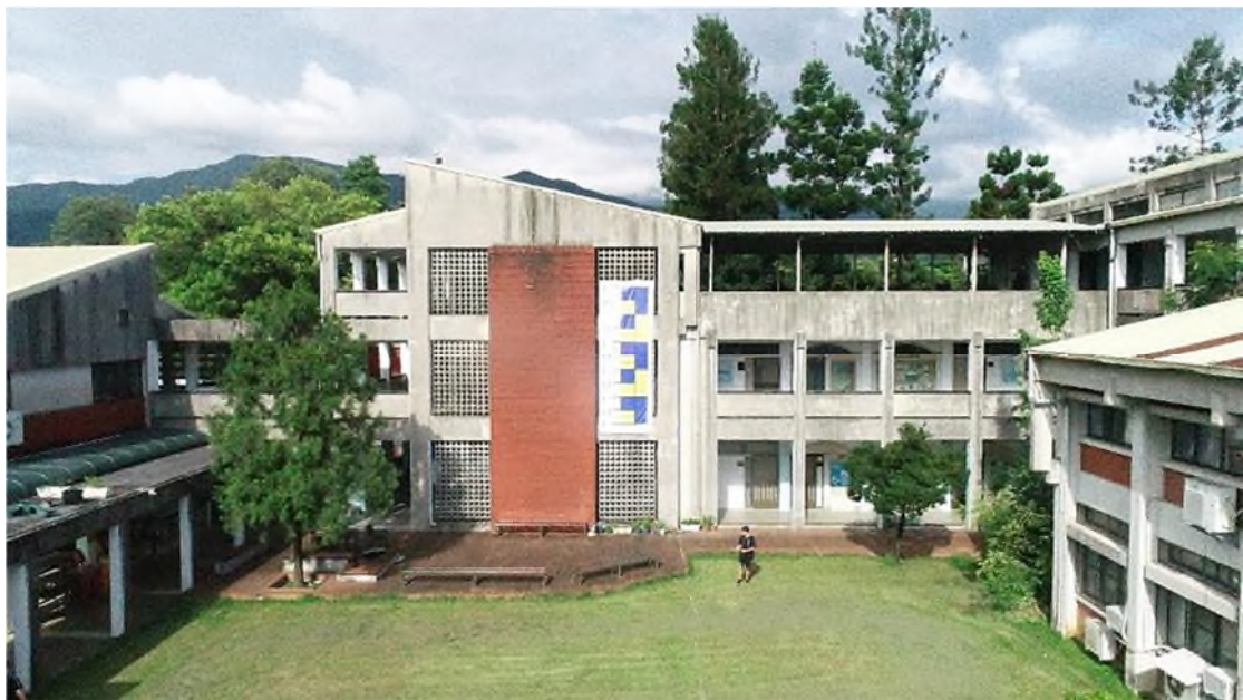
圖 6-5 UAV 距離標尺 30 公尺之標尺(UAV 視角)
