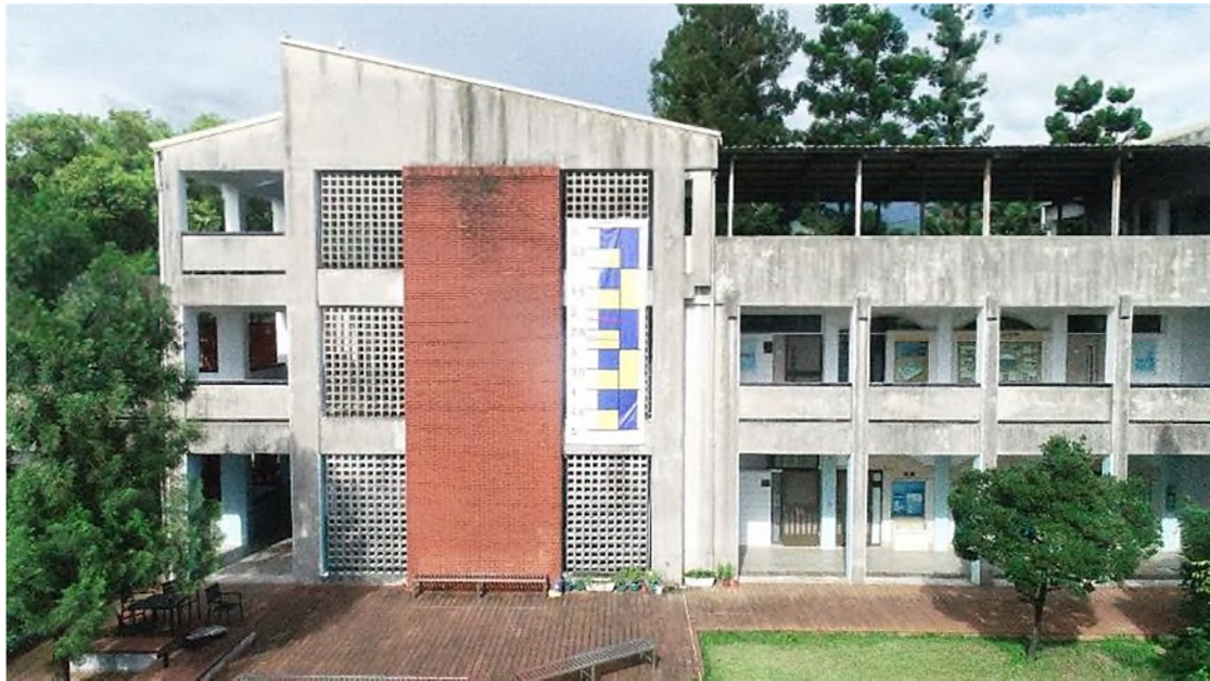
圖 6-4 UAV 距離標尺 20 公尺之標尺(UAV 視角)
