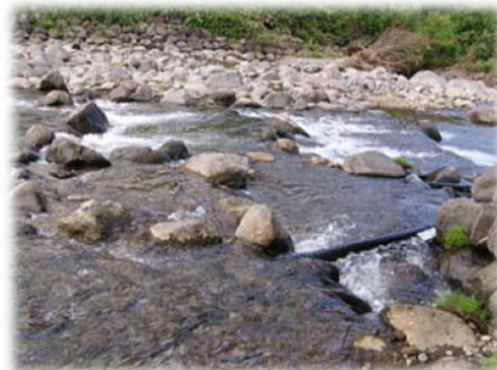
圖5-33 搭配設置丁壩工，引導形成多樣流況
