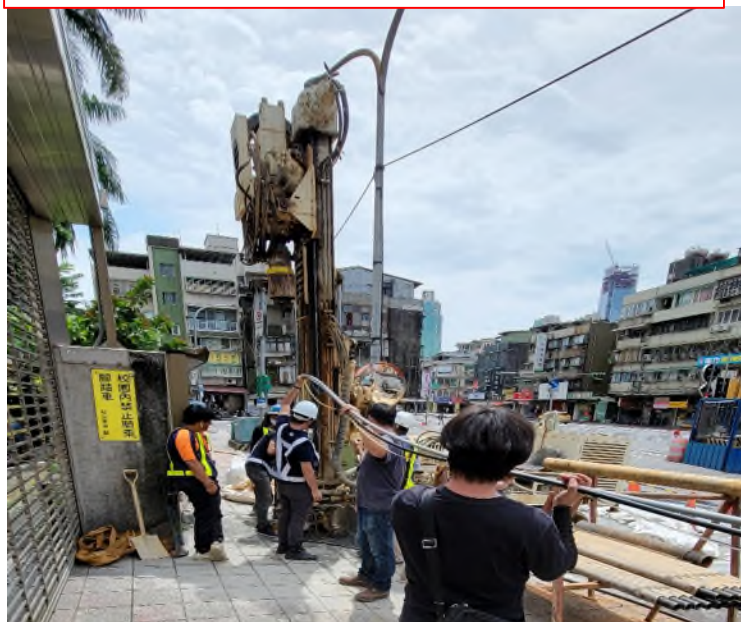
串接完成之孔隙水壓計放入井中
