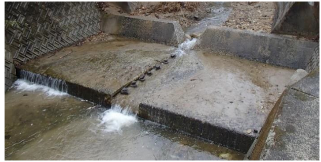
圖-6 凹槽魚道完工
