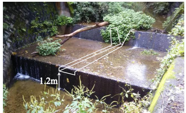
圖-5 凹槽魚道設置示意圖 (白線：挖掘線)
