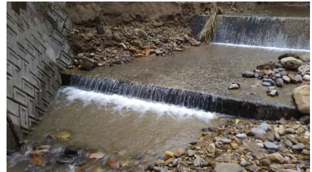
圖-7 颱風19號二週後土砂淤積而降低水面落差的狀況（2018年10月25日攝影）
