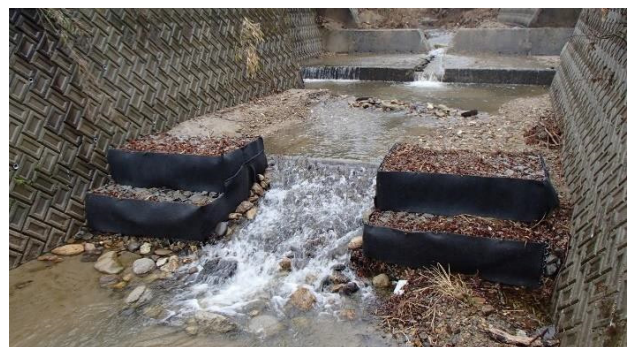
圖-9 箱型石籠設置後的土砂淤積狀況
