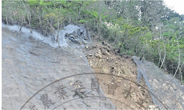
圖 2-2 現場網材脫落狀況
