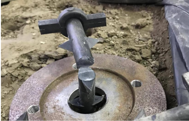
圖 4-3 刺刀形錨固釘於施作過程中斷裂
