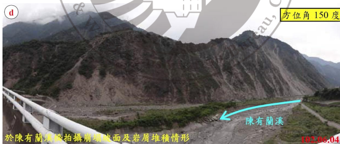
圖 4.4 實地崩塌及岩屑堆積情形
