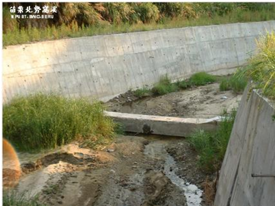
圖 1-2 固床工趾部的局部淘刷現象
