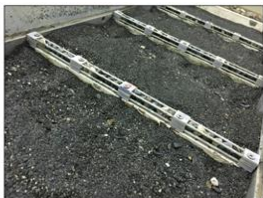
透 A 式 — 鋼骨間填充塊石
