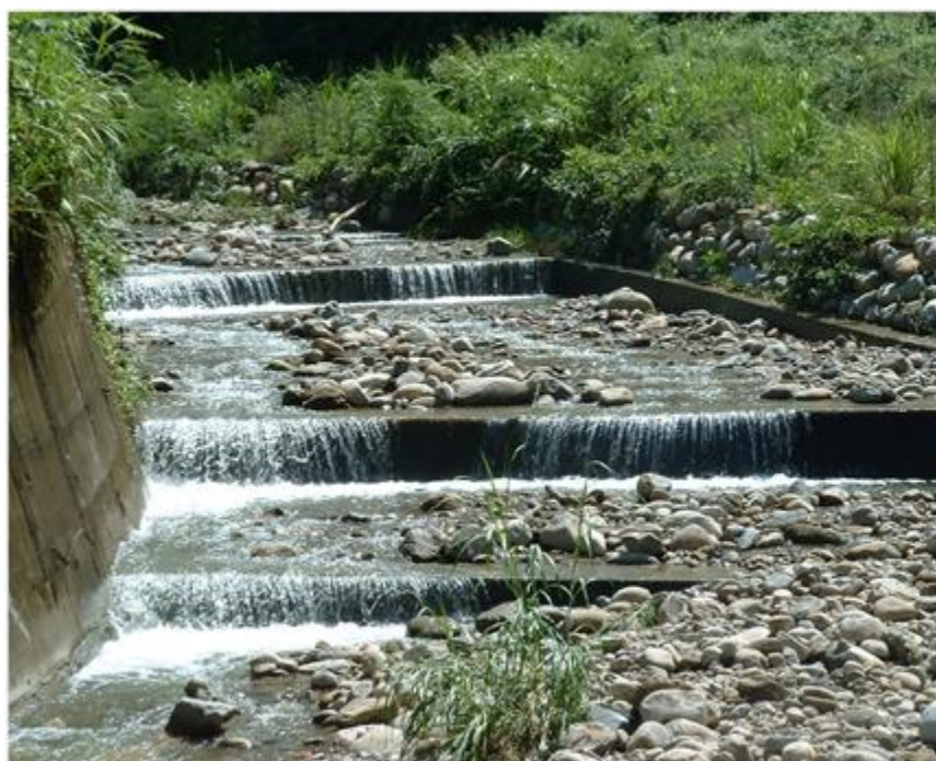
圖 1-1 固床工造成溪床水域的區間化
