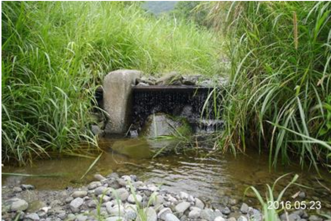
圖 1-3 鋼軌格柵透水式固床工
