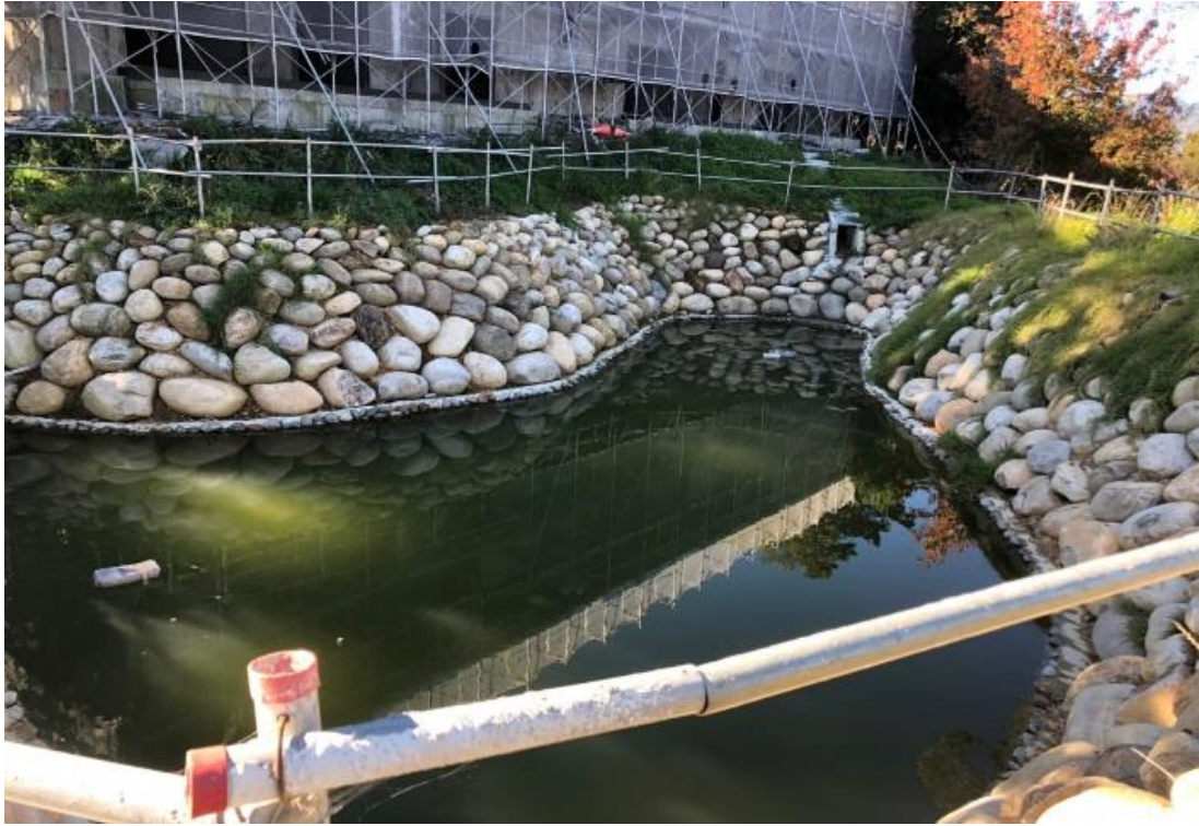
圖 3-3 沉砂設施池體及淤積程度檢查
