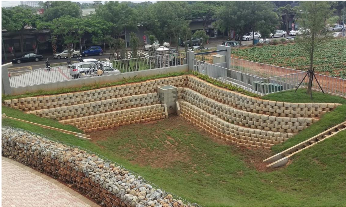
圖 2- 27 豎井出流結構之實際照片
