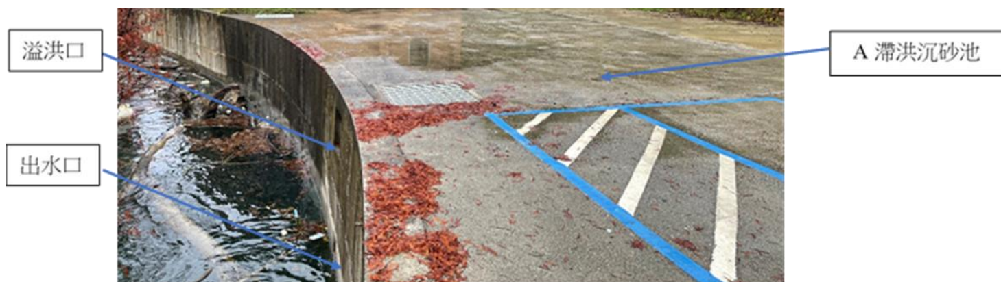
圖 4-30 檢修廠 - A 滯洪沉砂池現況圖
