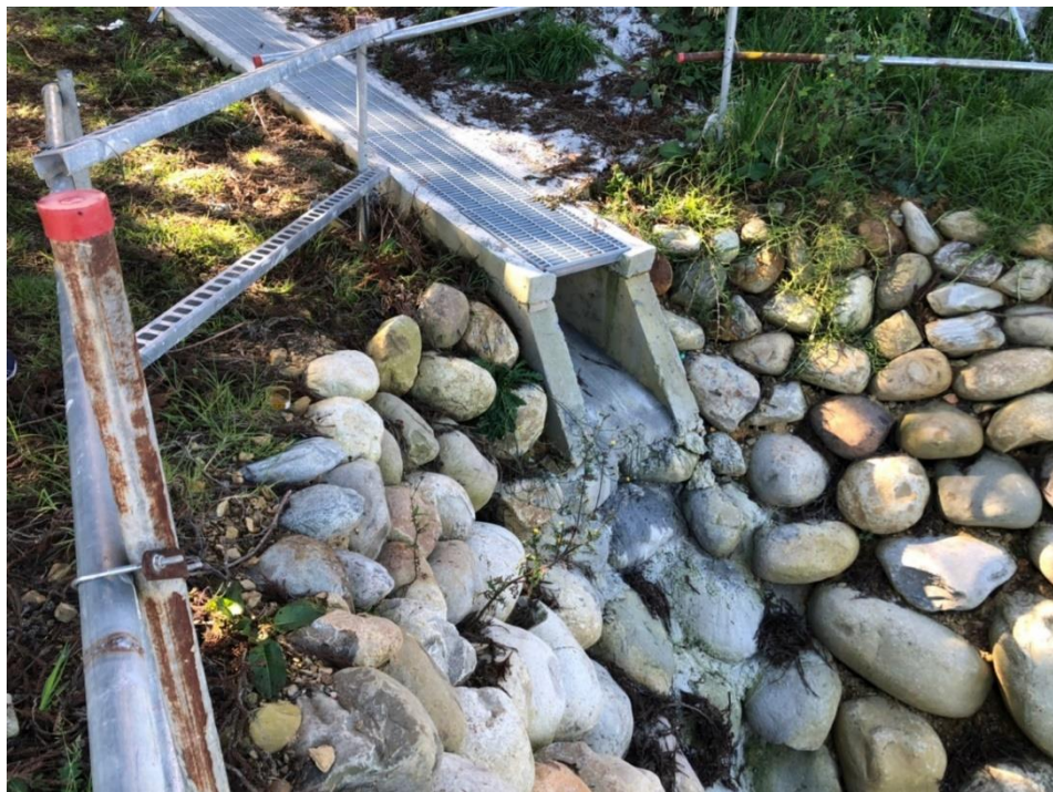
圖 4- 47 賓館興建 - 出水口及溢洪口(豎井)實照
