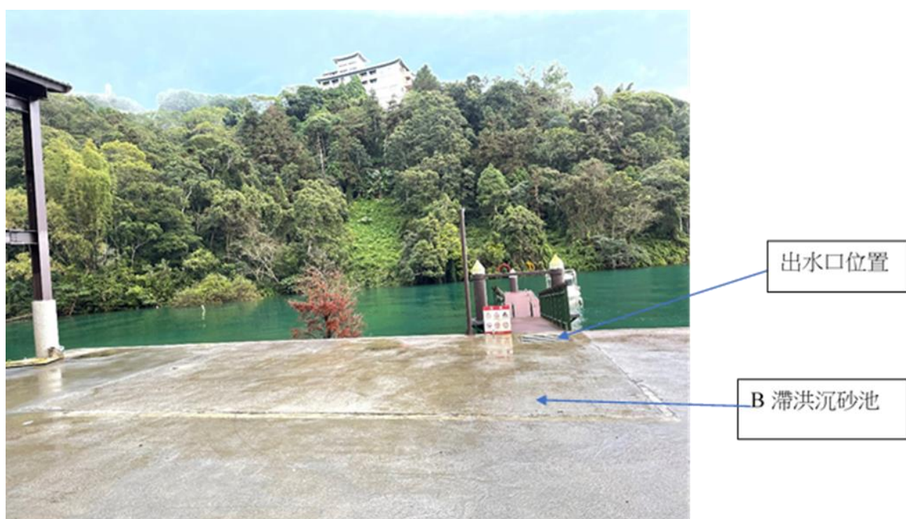
圖 4-31 檢修廠 - B 滯洪沉砂池現況圖
