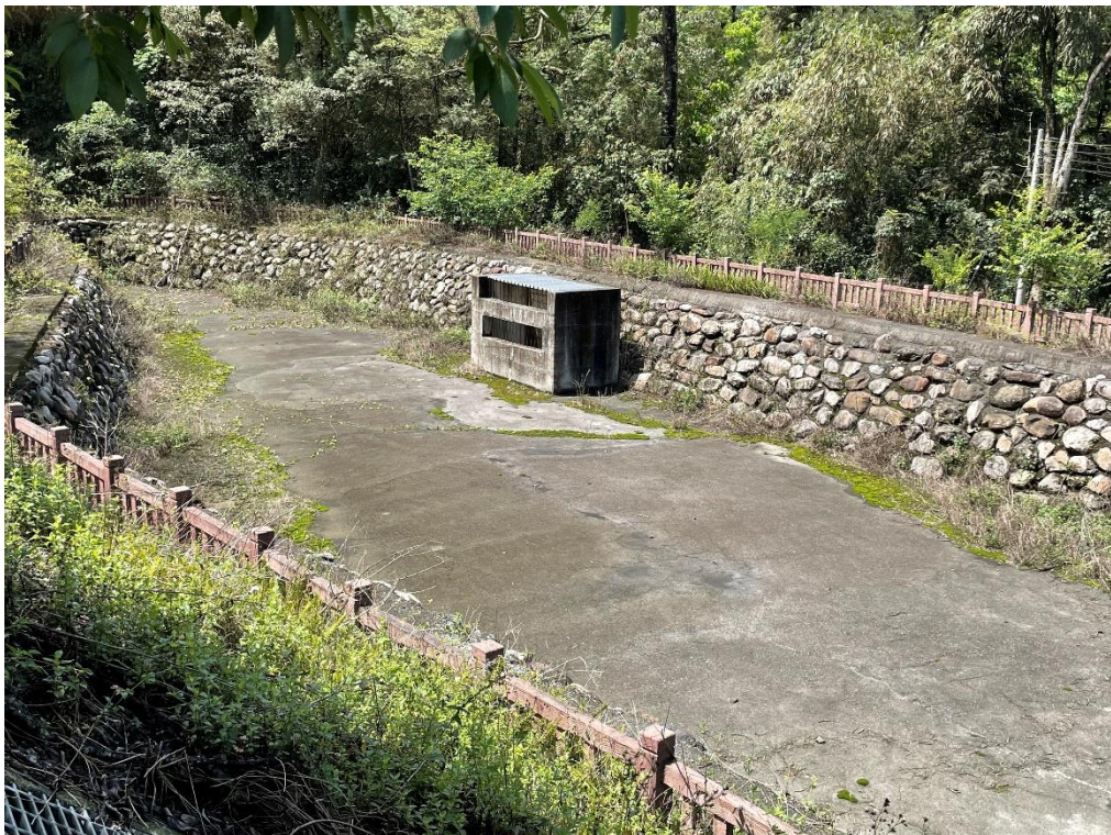
圖 4-9 農地開發 - 出水口及溢洪口實照
