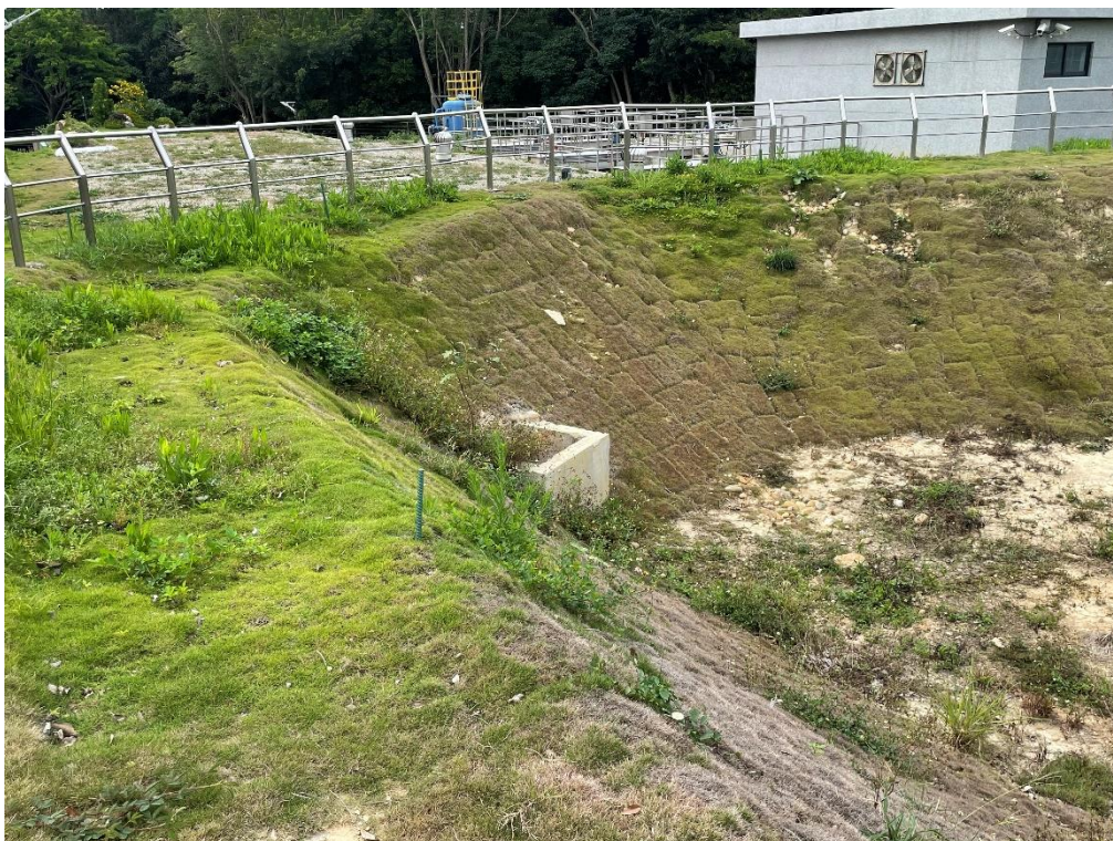
圖 4-22 污水處理廠 - E1 池出水口實照
