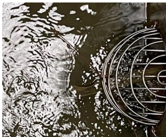
圖 4- 39 檢修廠 - 半球型攔汙柵實照
