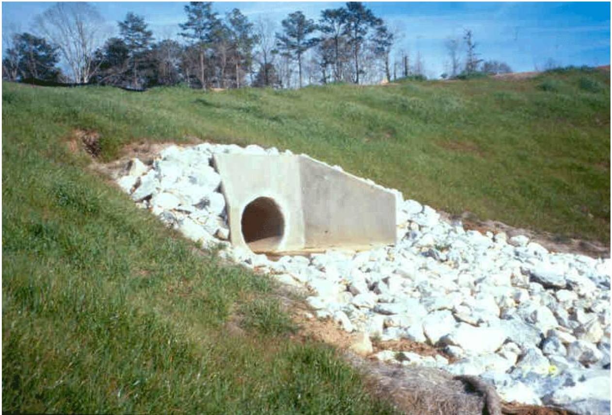
圖 2- 11 沉砂設施入流結構實際照片
