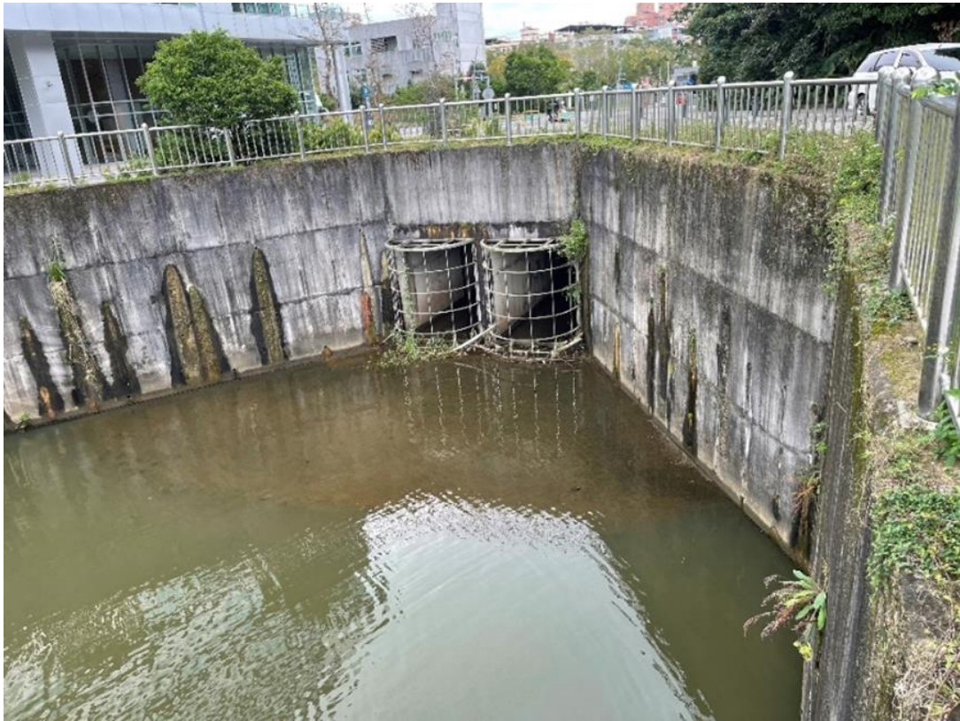
圖 4- 56 園區興建 - 出水口下游實照(既有溢流堰調節池)
