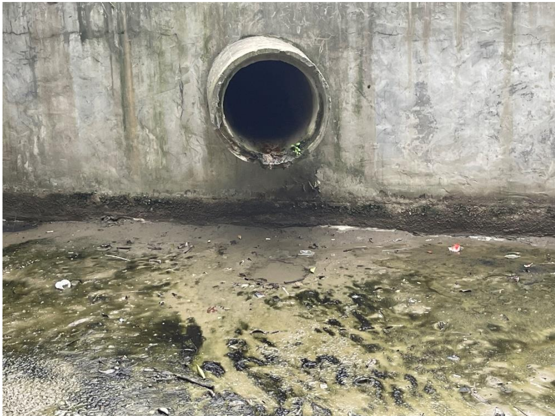
圖 4- 84 水庫防淤 - 隧道出水口臨時滯洪沉砂池入水口
