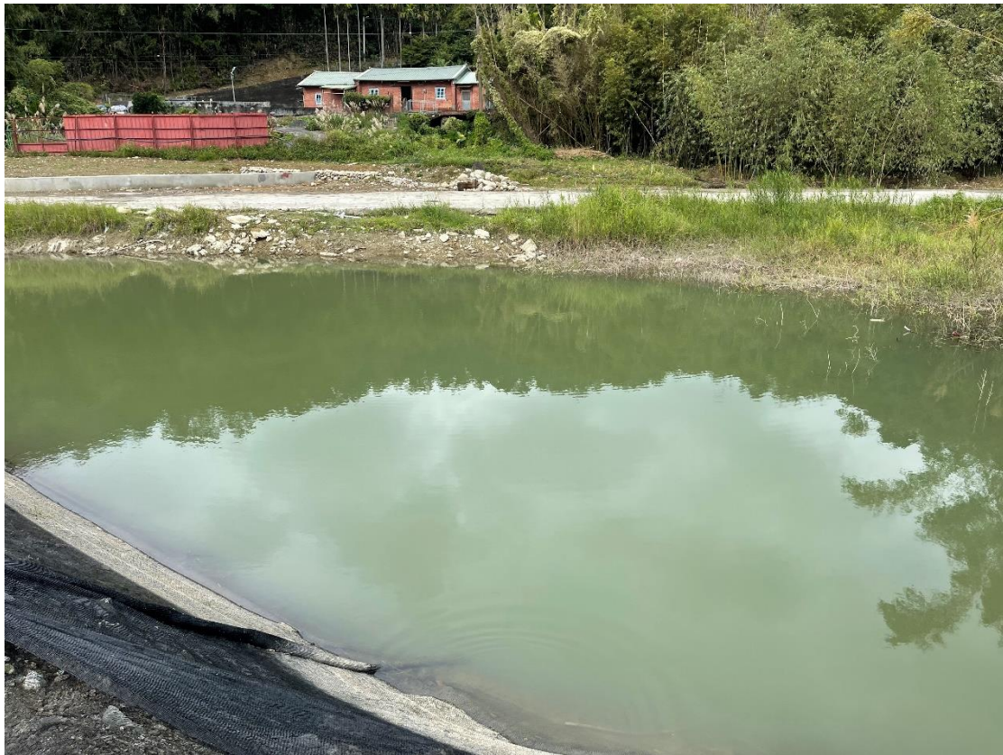
圖 4- 74 水庫防淤 - DET1 滯洪沉砂池實照
