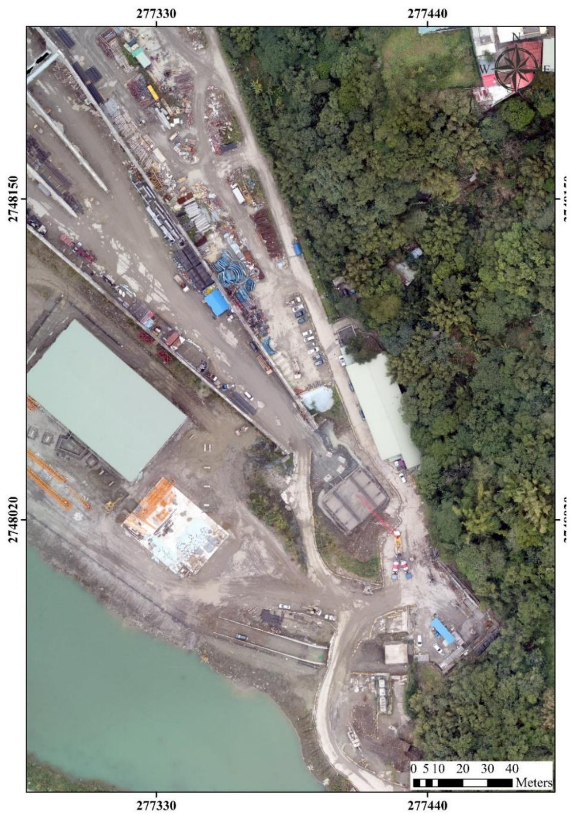
圖 4-70 水庫防淤－隧道出水口計畫範圍空拍影像成
