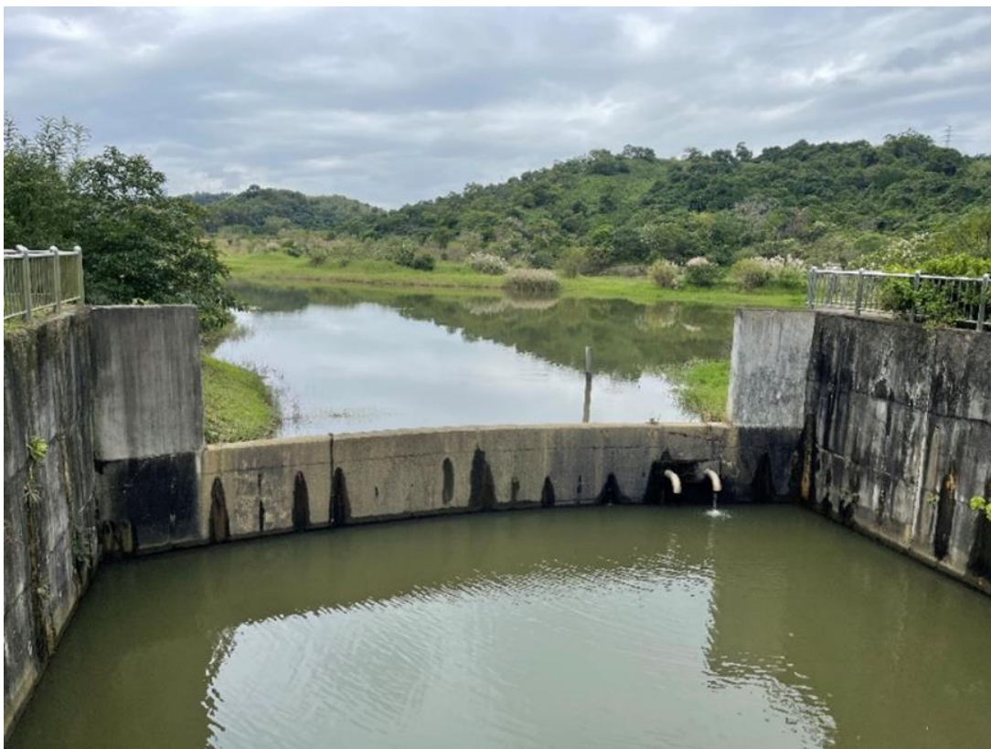
圖 4- 57 園區興建 - 出水口上游實照(既有溢流堰調節池)
