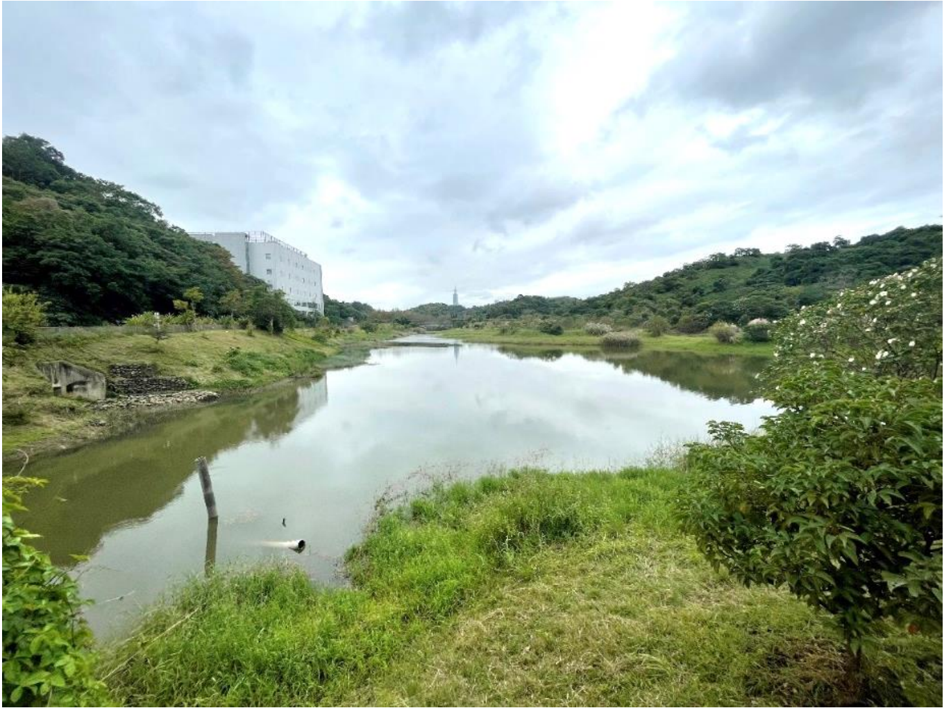
圖 4- 53 園區興建 - 滯洪沉砂池全景圖
