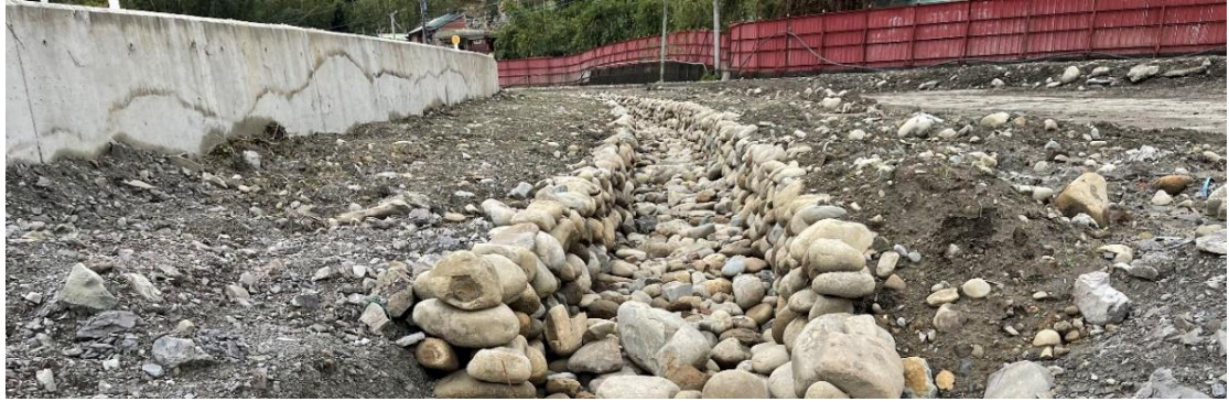
圖 4- 83 水庫防淤 - DET1 池(UB4 砌石溝)實照
