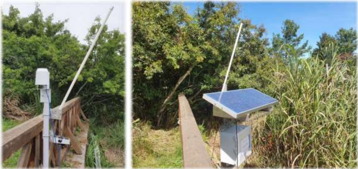
圖 4-35 依照傳輸方向調整天線角度
