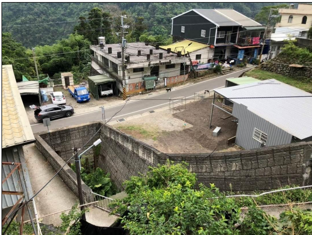
圖 4-8 5 月 13 日教會旁小溪與右側沖毀建物之基地現況
