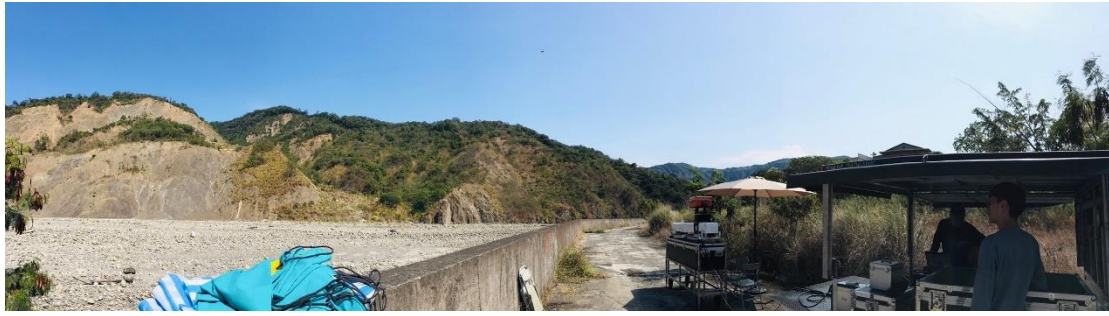
圖 3-3 寶來研究區現場邊坡概況
