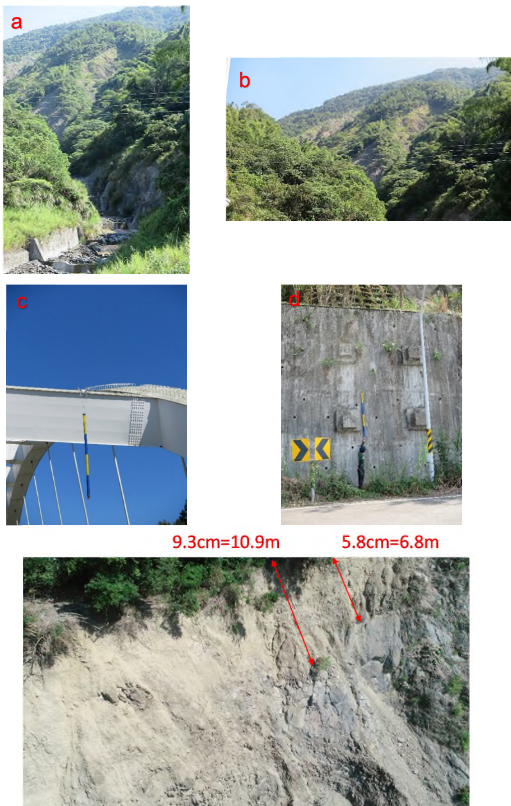
圖 4-7 紅水仙土石流之邊坡表土及崩積層測量狀況
