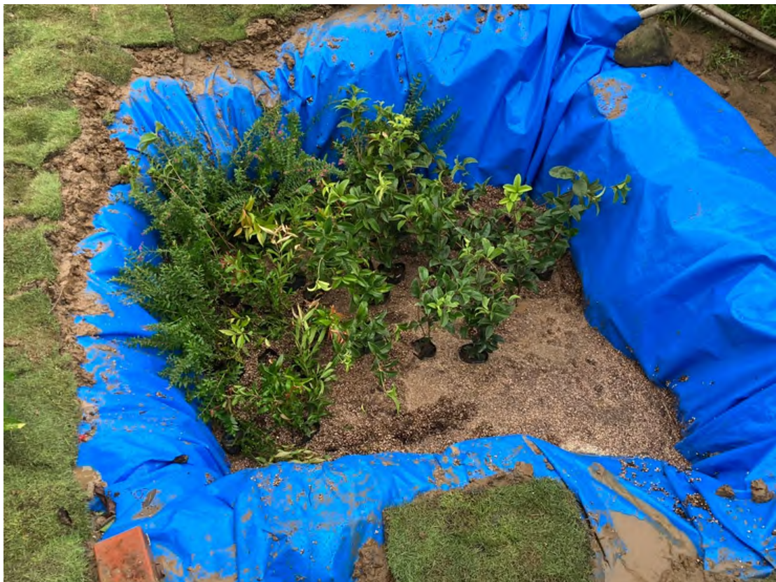
圖 2- 18 植生滯留槽完工圖(2021.09.14 拍攝，當天雨天)
