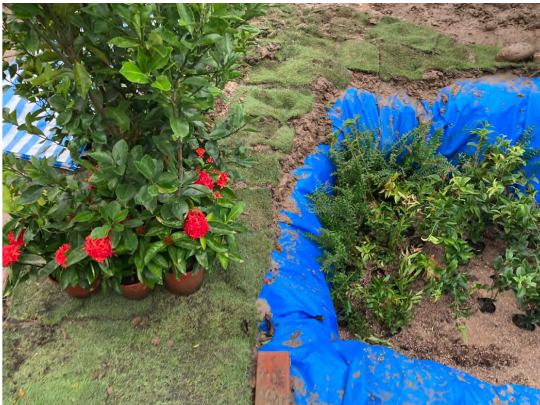
圖 2- 21 植生滯留槽種植植栽照片(2021.09.14 拍攝，當天雨天)
