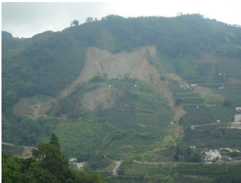
圖 3.1 嘉義油車寮崩塌地實景照片
