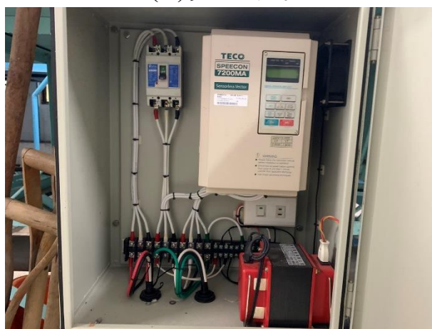
(B)步進馬達控制面板
