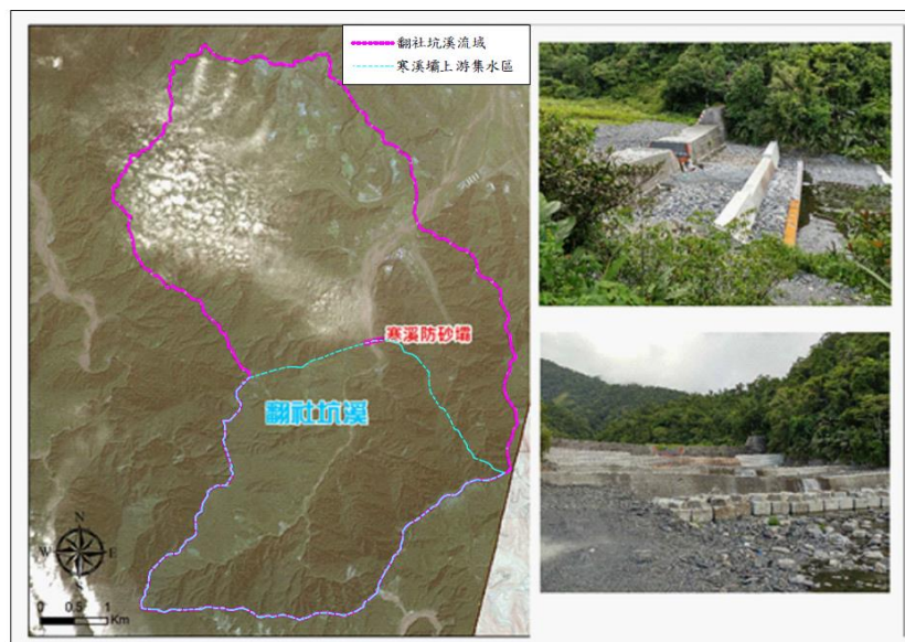
圖 1-1 本計畫分析標的之水土保持設施(寒溪防砂壩)
