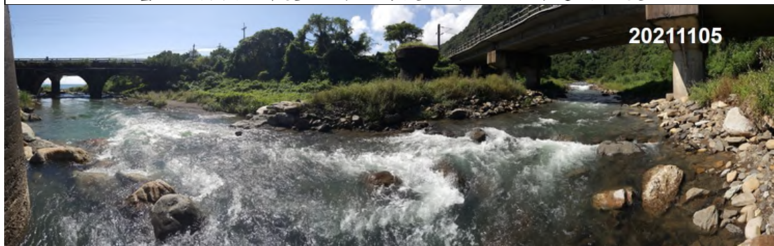
固床工#1-#2 間高程持續自我調節，已有 6 道石組出現。
