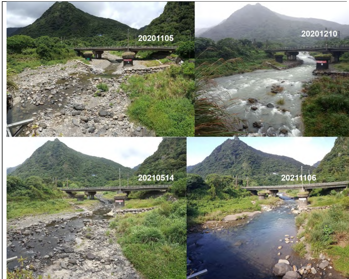
舊大溪橋拍攝優化測試前後固床工#1 周遭的改變
