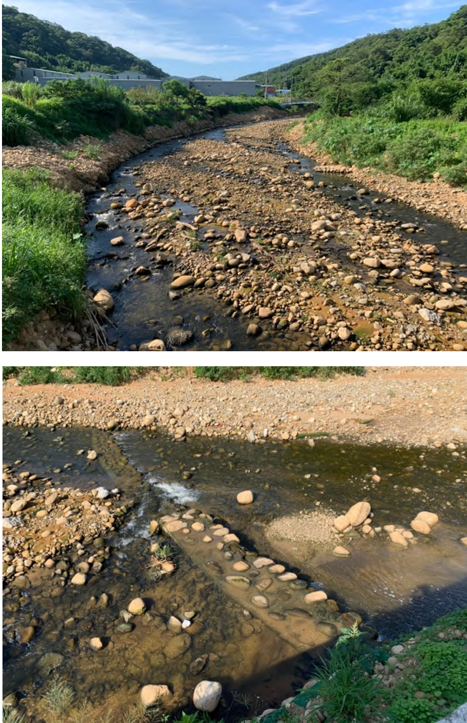
圖 4-14 水仙溪工程現況圖
