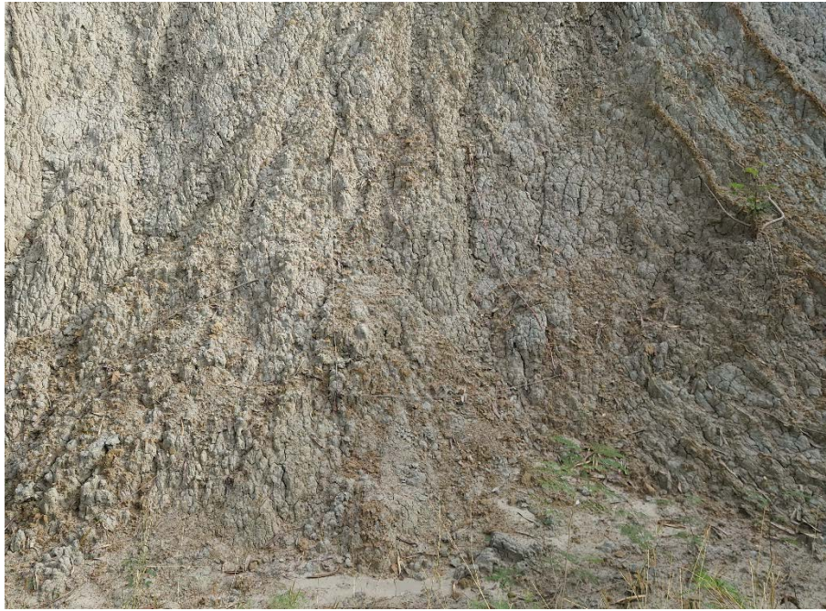
圖 2-58 現地試驗坡面初始概況(2021/11/4)
