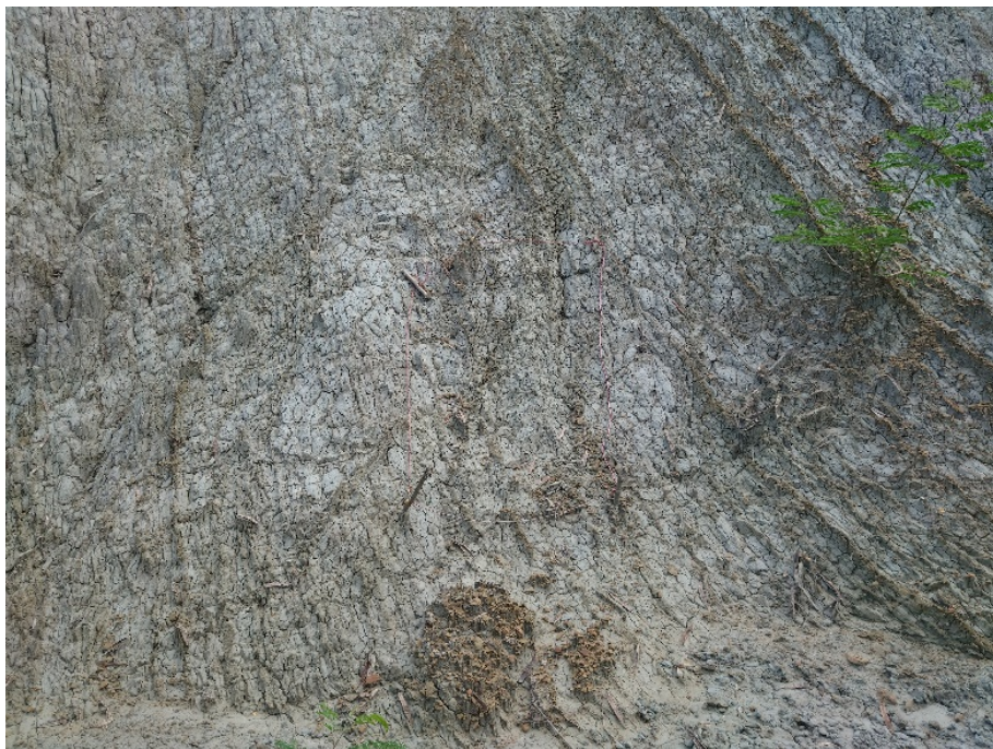
圖 2-55 現地試驗坡面初始概況(2021/7/13)
