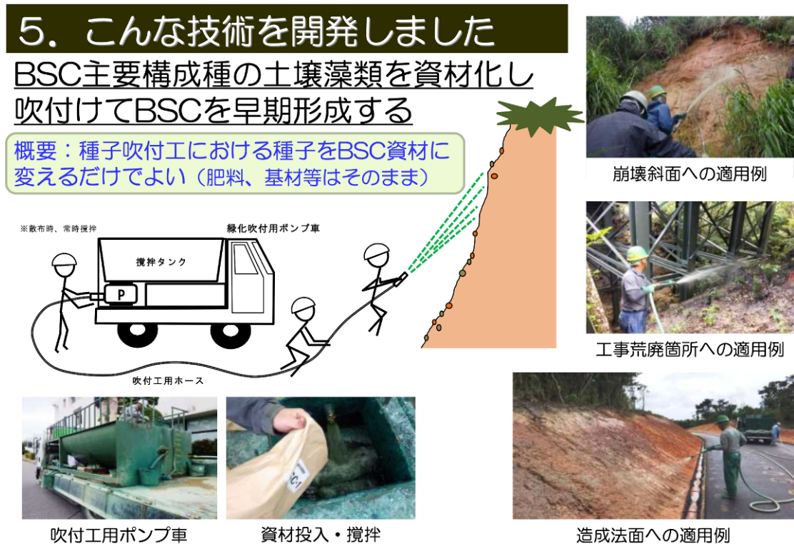
圖 1-8 採用噴植方法施工的 BSC 土壤改良案例
