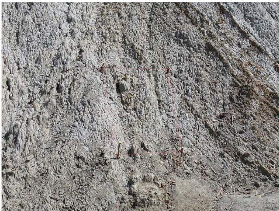
圖 2-51 現地試驗坡面初始概況(2021/3/16)
