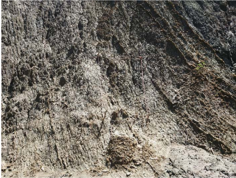
圖 2-54 現地試驗坡面初始概況(2021/6/9)
