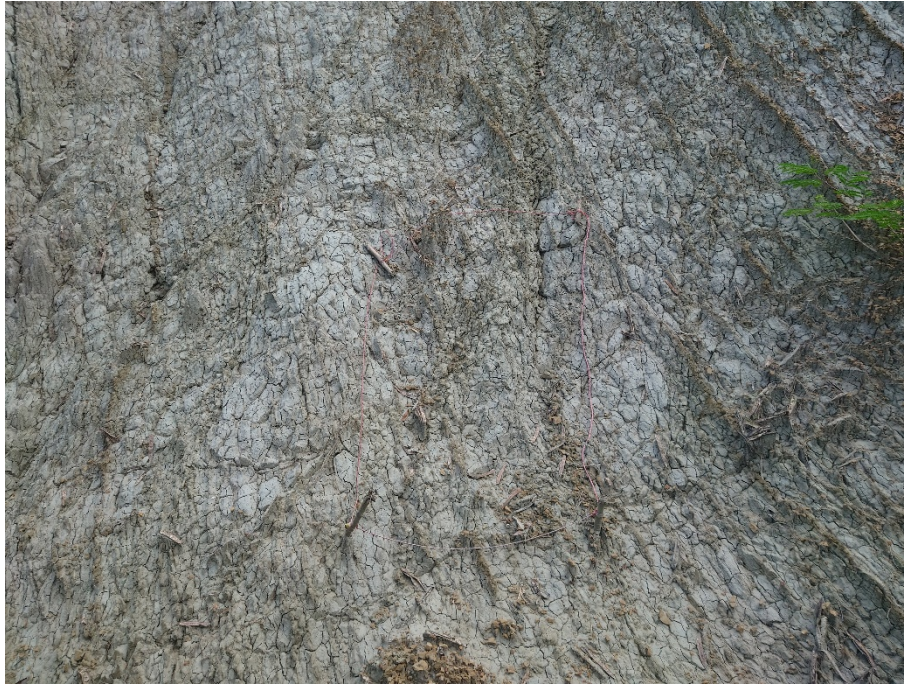
圖 2-56 現地試驗坡面初始概況(2021/8/3)
