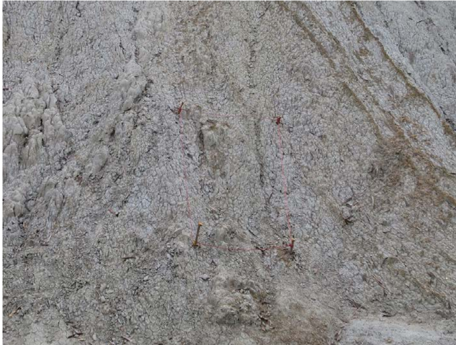
圖 2-52 現地試驗坡面初始概況(2021/4/7)
