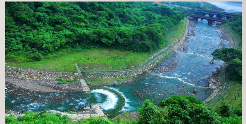
大溪溪現況照片
