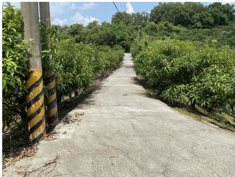
圖 3-16 土壩壩頂現場狀況
