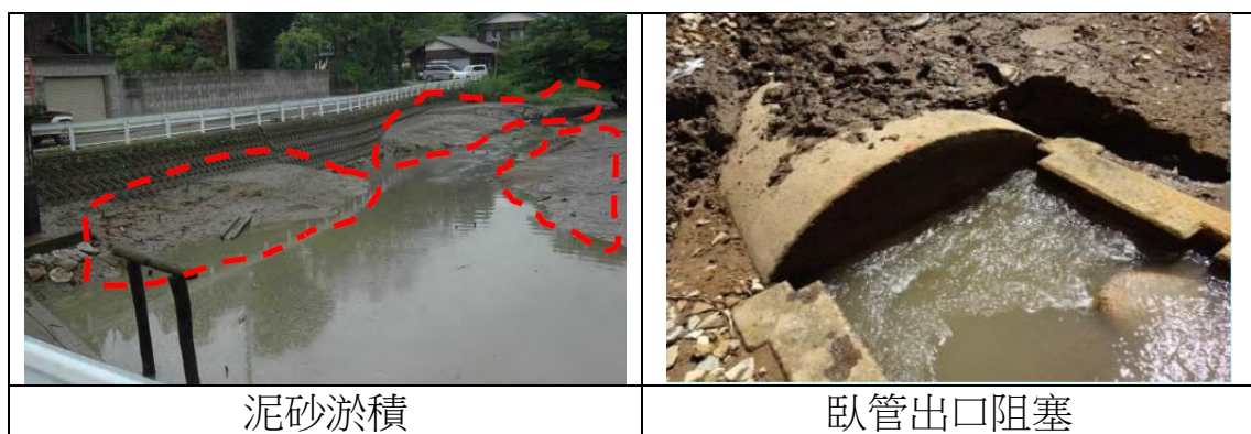
圖 3-8 築壩式農塘閘門及其他破壞態樣
