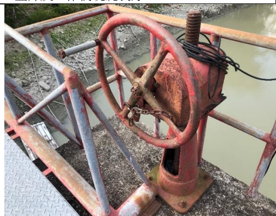
8.閘門吊門機組良好。
