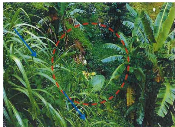
自然土堤崩塌流失
