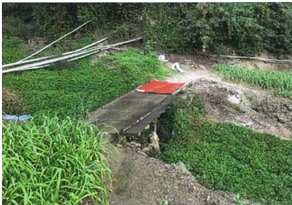
既有跨溪道路
