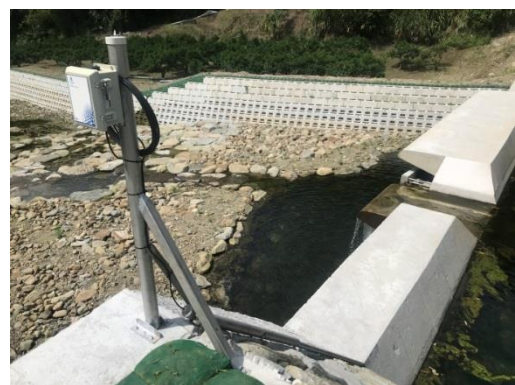
(b) 主機架設於階段式固床工之翼牆頂面
