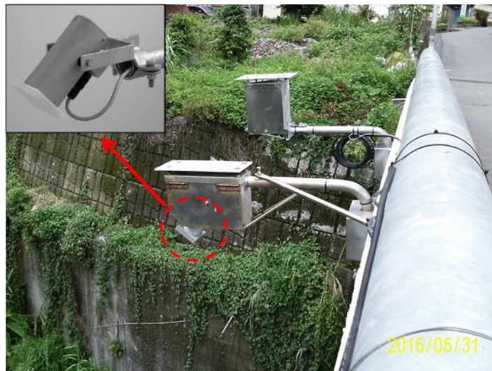
圖 3-56 自計式雷達波流速儀於現地架設示意圖
