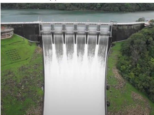
(g) 溢洪坡道
