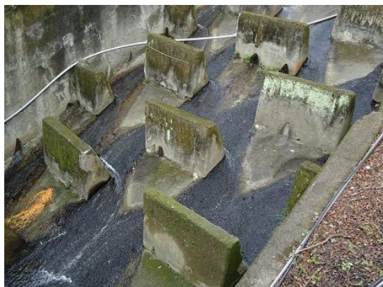
(e) 齒坡消能工
