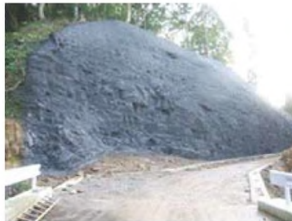
圖 3.9 噴凝土噴覆工
