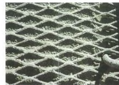
圖 2.14 混凝土澆置後的狀況
