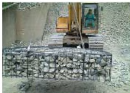
圖 2.5 銲接鋼線網蛇籠
