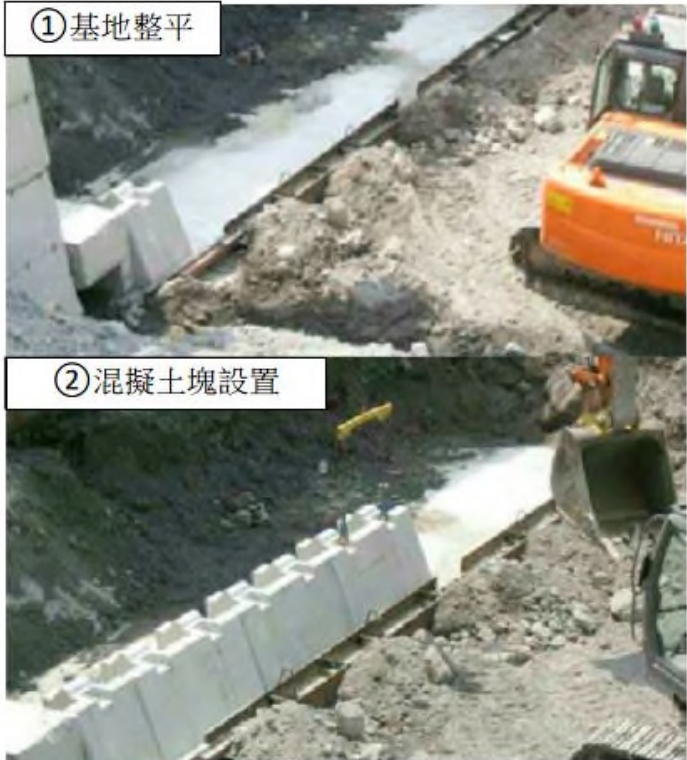
圖 2.30 無人化施工完成自立式模板混凝土塊施工案例
