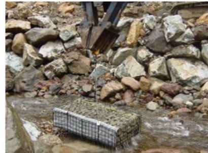
圖 2.6 吊掛式箱型蛇籠的組立
