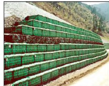
圖 2.5 銲接鋼線網蛇籠
