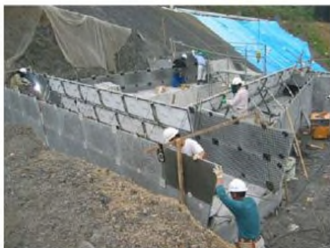
圖 2.11 施工案例(不適用於曲率半徑小於 10m 處)
