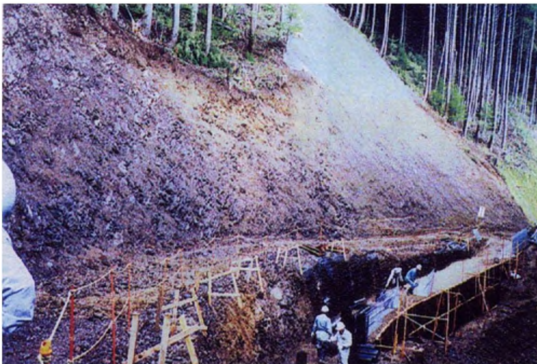
圖-2.7 挖方邊坡正下方擋土牆的施工狀況案例
