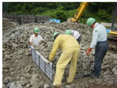
圖 2.7 箱型蛇籠的充填
