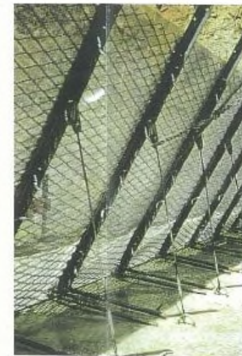
圖 2.12 鋼製殘留模板的概要
