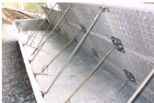
圖 2.11 施工案例(不適用於曲率半徑小於 10m 處)
