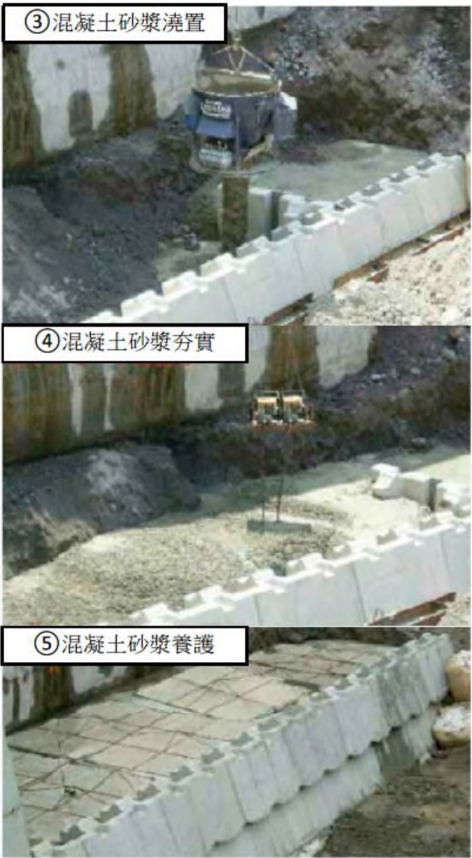
圖 2.30 無人化施工完成自立式模板混凝土塊施工案例
