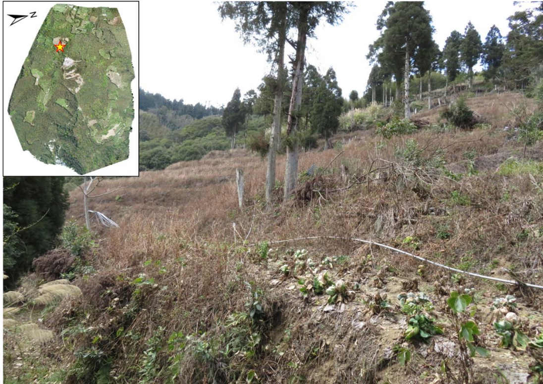
圖 5-17、崩塌地冠部已被開墾為等高線梯田。(拍攝日期 2021/02/23， 拍攝方位角 315 度)
