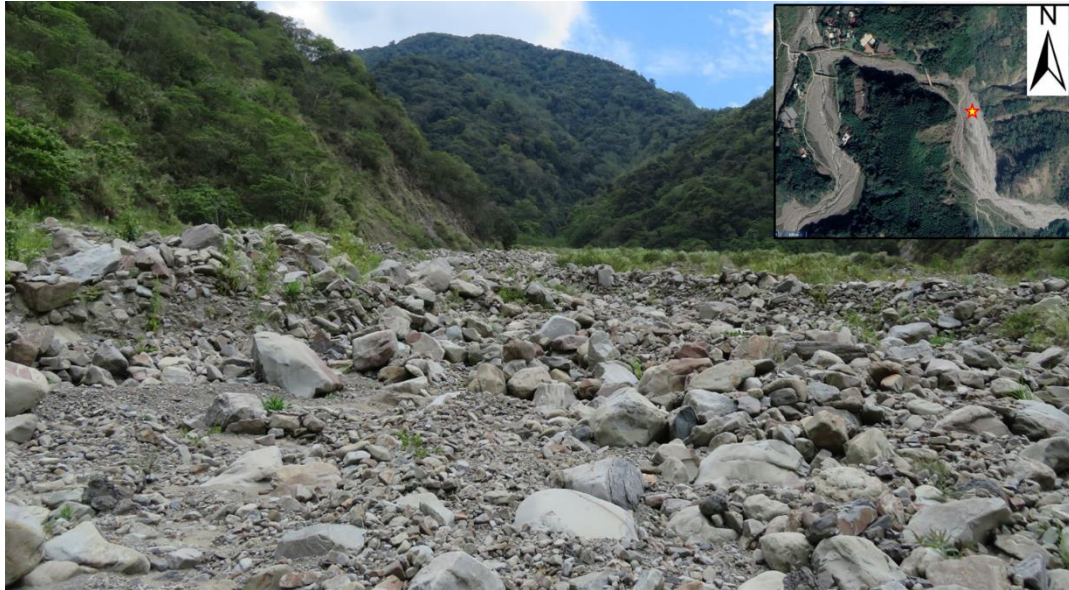
圖 5- 40、河道內大量土石材料堆積。(拍攝日期 2021/5/5，拍攝方位角 180 度)
