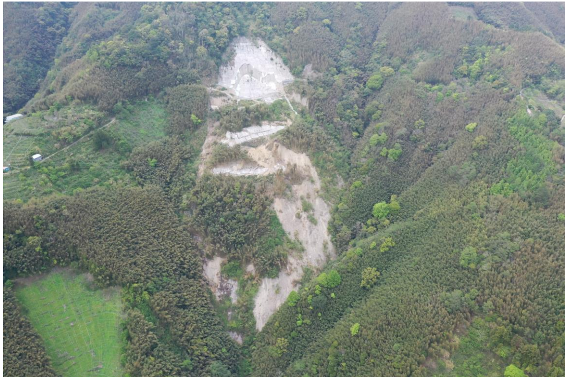
圖 5-15、T002 之現生崩塌地。
