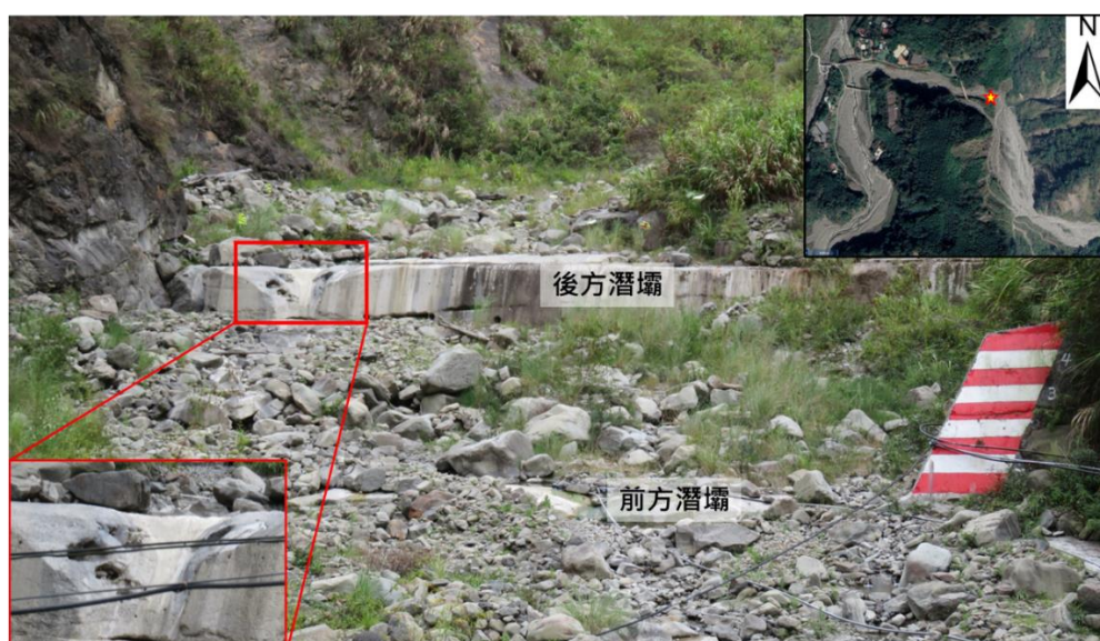
圖 5-39、2 座潛壩結構體狀態。(拍攝日期 2021/5/5，拍攝方位角 90 度)
