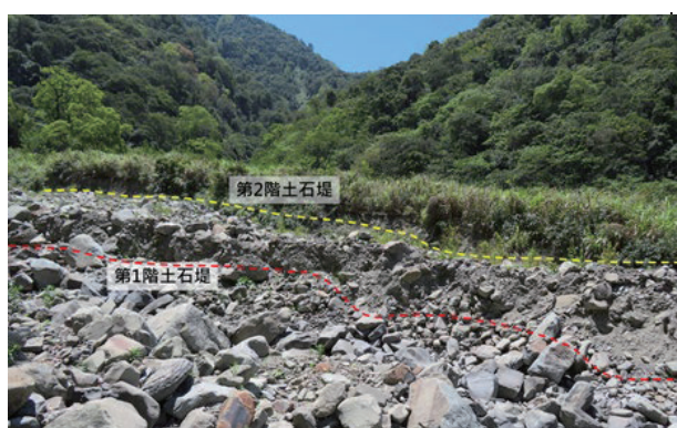
圖 10. 調查點②土石堤縱剖面
