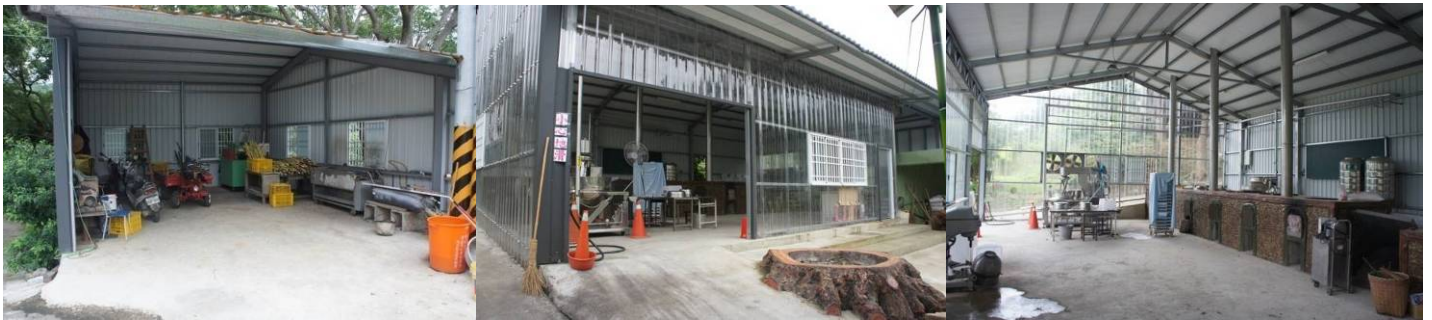
圖 11、經水土保持局協助改建及周邊環境美化後，目前規劃作為甘蔗加工的洗甘蔗、榨甘蔗與甘蔗製糖空間。
