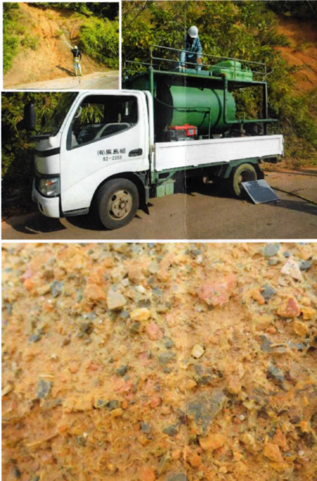
圖 2-13 BSC 坡面噴植施工作業情形 (日本工營，2017)
