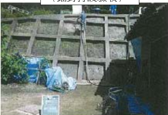
〈水泥砂漿噴凝情形〉
