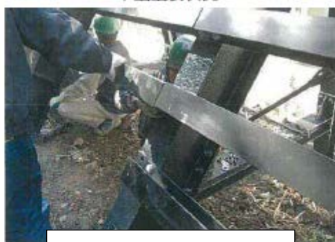
〈鋼製壁材安裝情形〉
