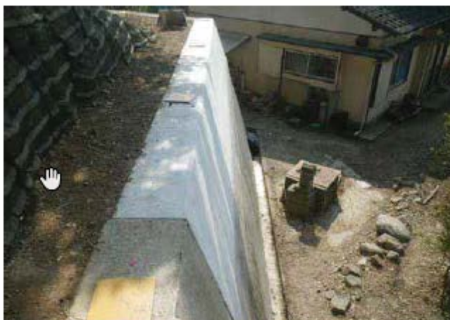
〈拆除混凝土（部分區段）、基礎設置情形〉
