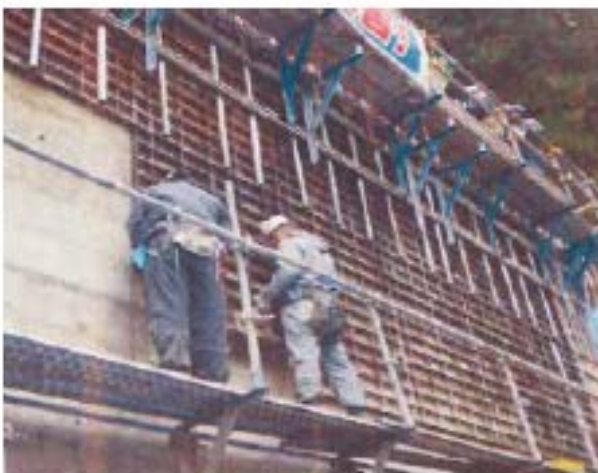
〈下游面施工情形〉
