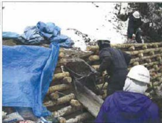
背面堆土情形
