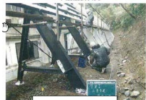
〈面層塗裝情形〉
