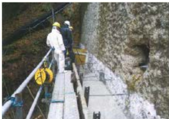
〈混凝土澆置情形〉
