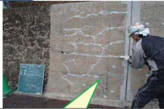
龜裂處注入作業情形
