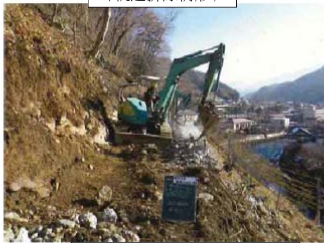
〈基礎混凝土護牆拆除情形〉
