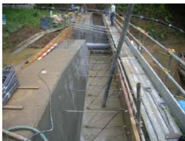
〈混凝土澆置情形〉
