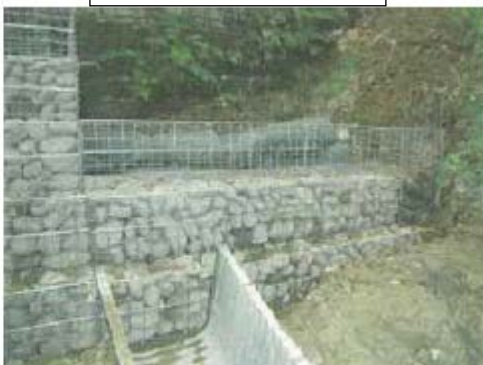
〈格籠組立情形〉
