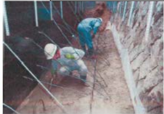
〈鋼筋施工情形〉
