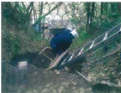
〈堆積土砂撤除情形 4〉
