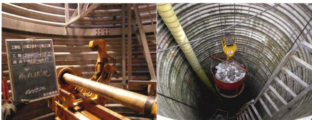
《施工情形》（左：排水鑽探鑽孔、右：進行填石）
