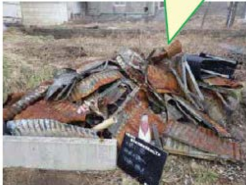
《施工情形（拆除後）》
