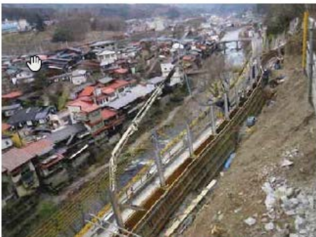
〈混凝土澆置情形〉
