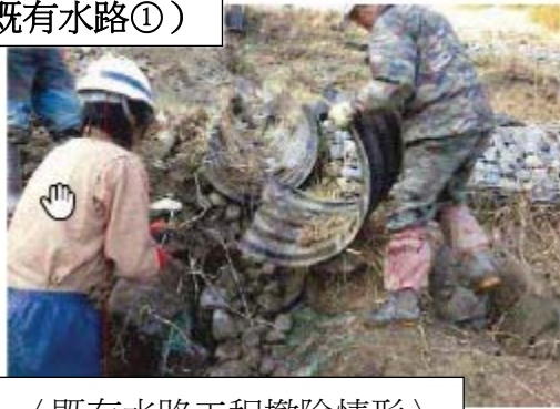
〈既有水路工程撤除情形〉
