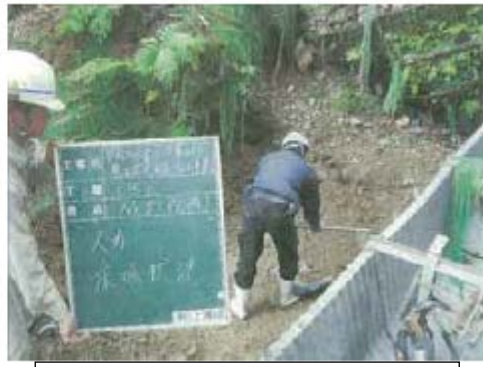
〈地面挖掘情形（人力）〉
