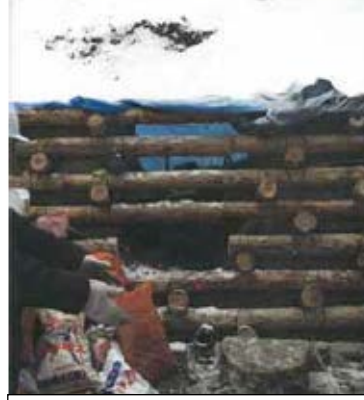
水路工出水口施工情形
