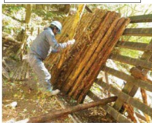
《施工情形（拆除）》
