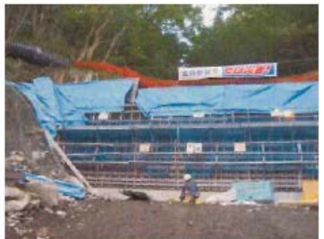
〈下游面施工情形全景〉
