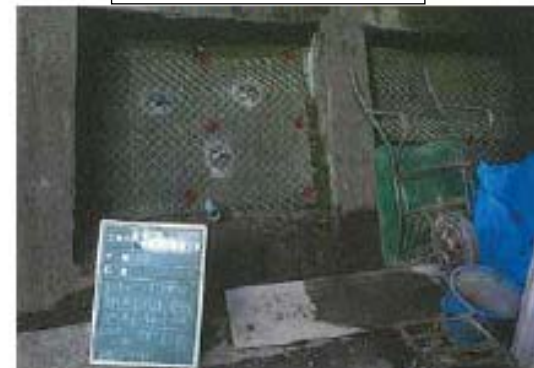
〈錨釘打設驗收〉
