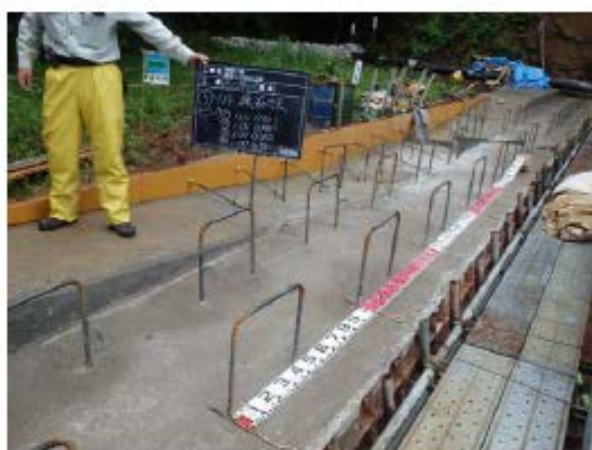
〈植筋尺寸確認情形〉
