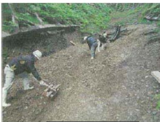
〈斜面整地情形〉
