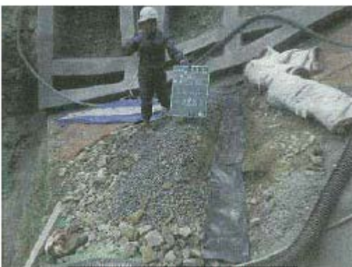
〈防水墊鋪設情形〉
