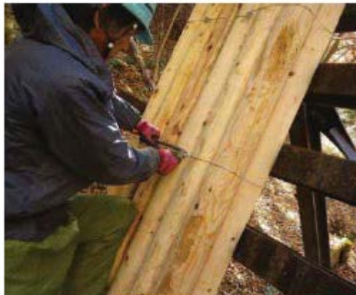
《施工情形（更換）》
