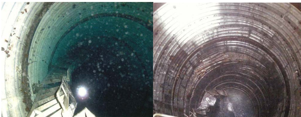
《對策實施前》（左：儲水情形、右：幫浦排水後（下部埋設狀況及彎曲處））
