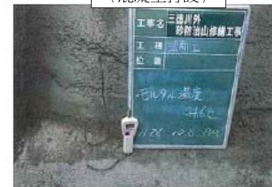
〈水泥砂漿噴凝溫度量測〉
