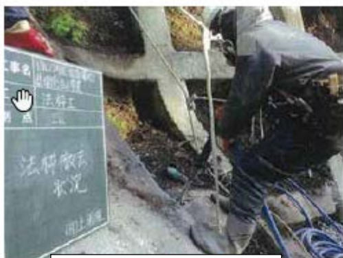
〈格框工拆除情形〉
