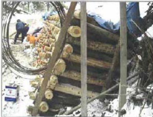
側邊施工情形
