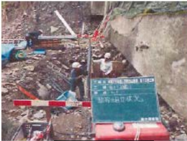
〈模版組立裝情形〉
