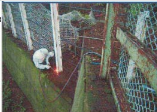
拆除損壞部件並更換
