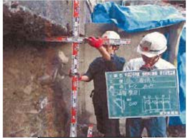
〈基礎淘刷部位檢測〉
