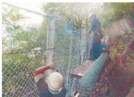
《施工情形（損壞部位拆除、更換）》
