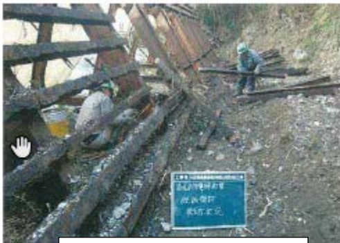
〈既有壁材撤除情形〉
