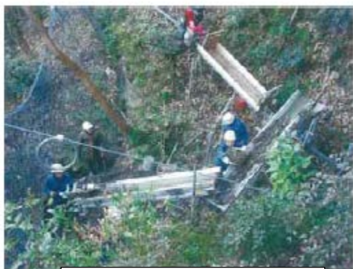
〈堆積土砂撤除情形 1〉
