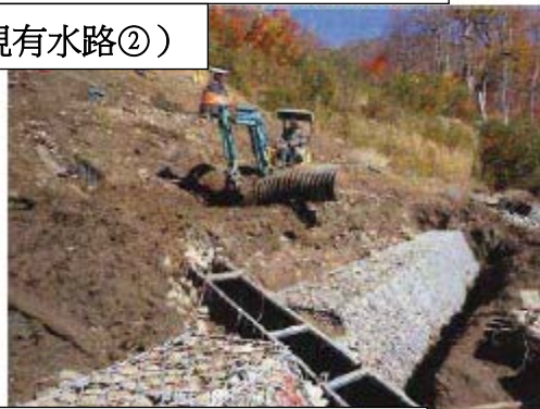
〈現有水路工程撤除情形〉
