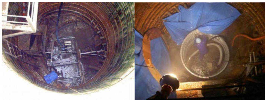
《集水井改修施工情形》
