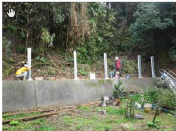
〈支柱設置情形〉
