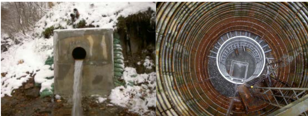
《對策實施後（大口徑排水管（出水口））》 《對策實施後（集水井改修後）》
