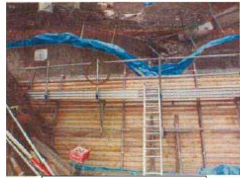
〈施工中正面情形〉
