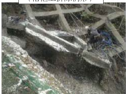
〈格框工拆除情形〉
