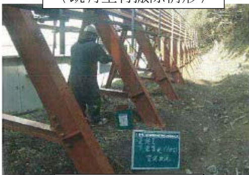
〈底層塗裝情形〉
