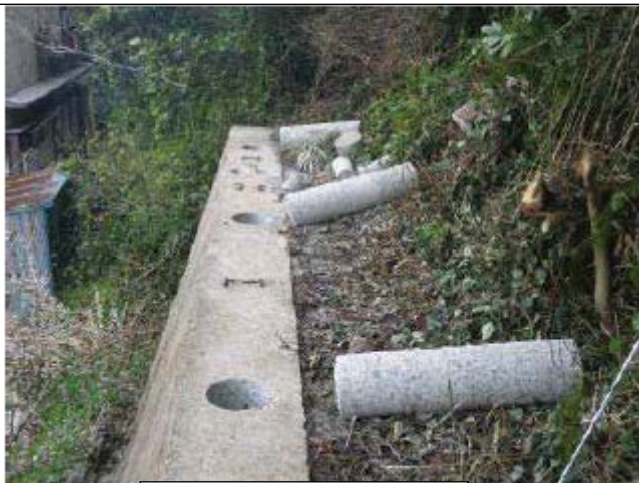
〈支柱孔開孔情形〉
