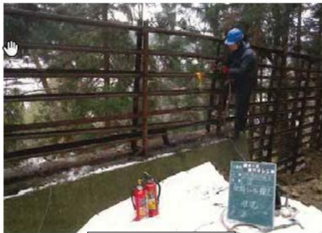
〈軌道拆除情形〉
