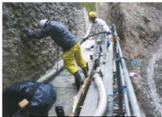
〈混凝土澆置情形〉
