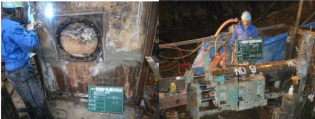
《大口徑排水管施工情形》
