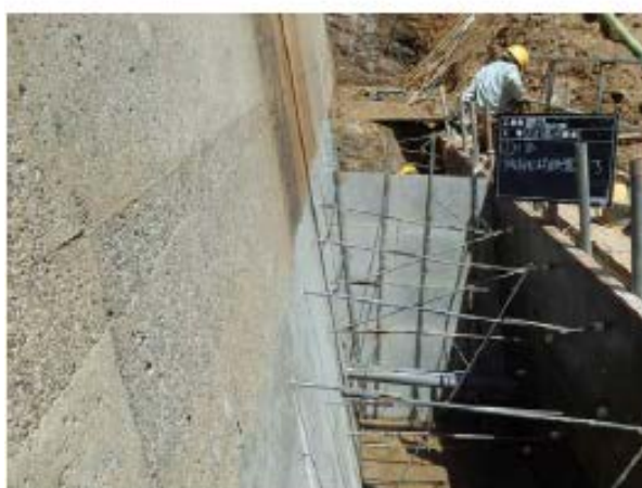
〈存留型模版設置完成情形〉
