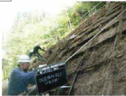
《施工情形（拆除木製格籠工）》
