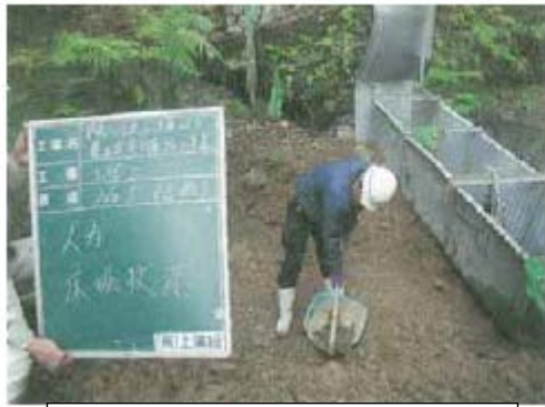
〈地面挖掘情形（人力）〉
