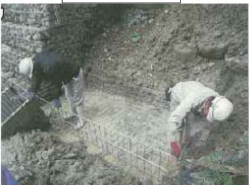
〈格籠組立情形〉
