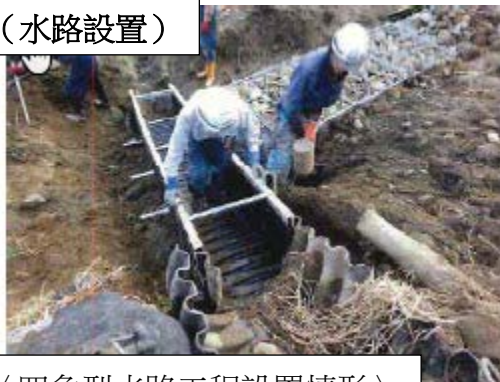
〈四角型水路工程設置情形〉
