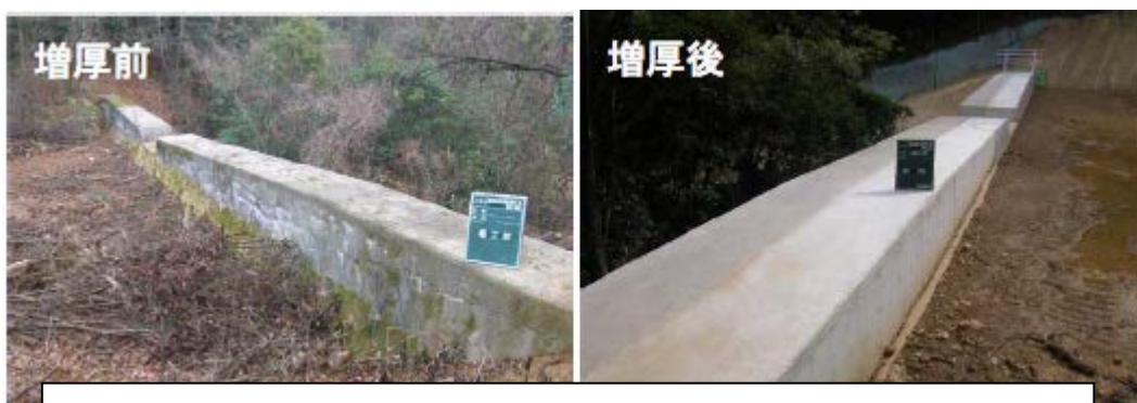
此防砂壩構造以目前技術基準來看斷面過小，因此以混凝土增厚。
