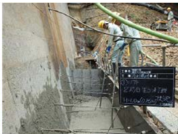
〈混凝土灌漿情形〉
