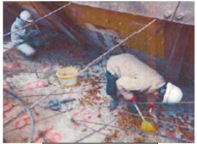
〈鋼筋工及清掃情形〉
