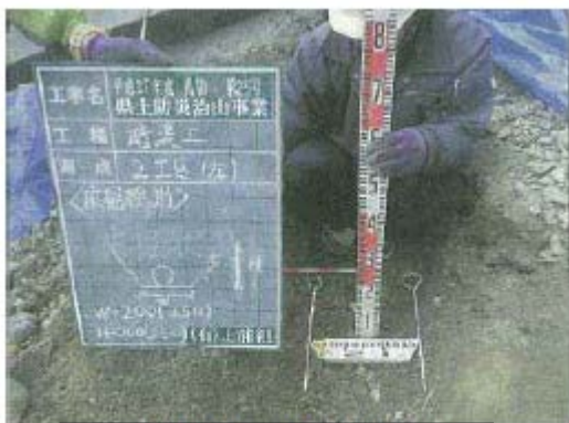
〈水路河床挖掘完成照〉
