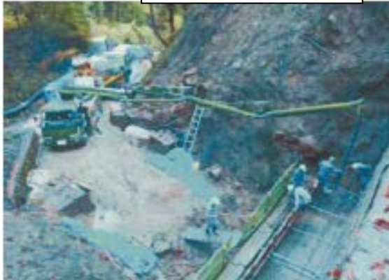
〈混凝土澆置情形〉
