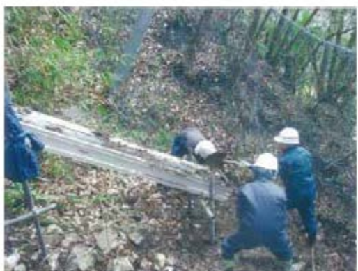
〈堆積土砂撤除情形 3〉
