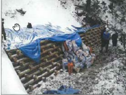
前面部位施工情形
