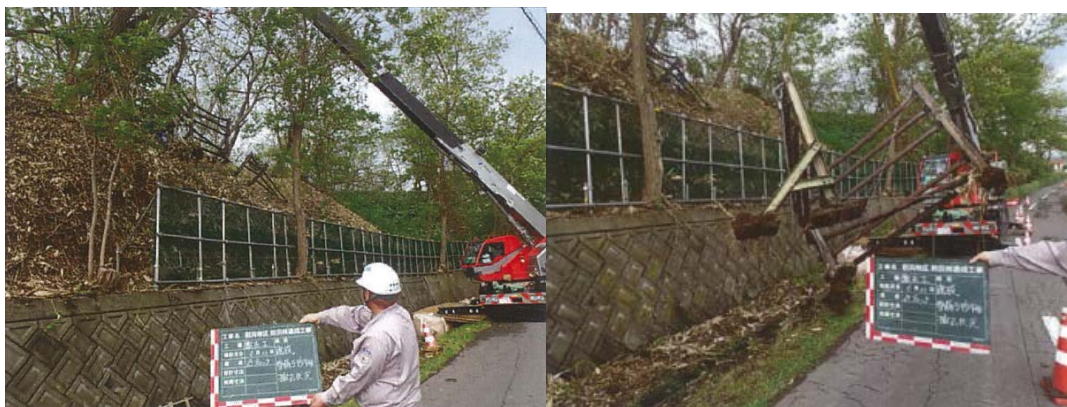
《施工情形》 依現行柵欄安裝標準重新安裝柵欄
