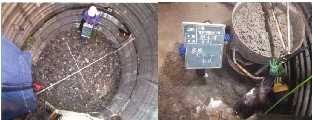
《施工情形》（左：填石完成、右：靜水層重新打設）
