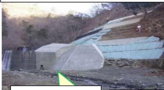
治山設施基礎部位
