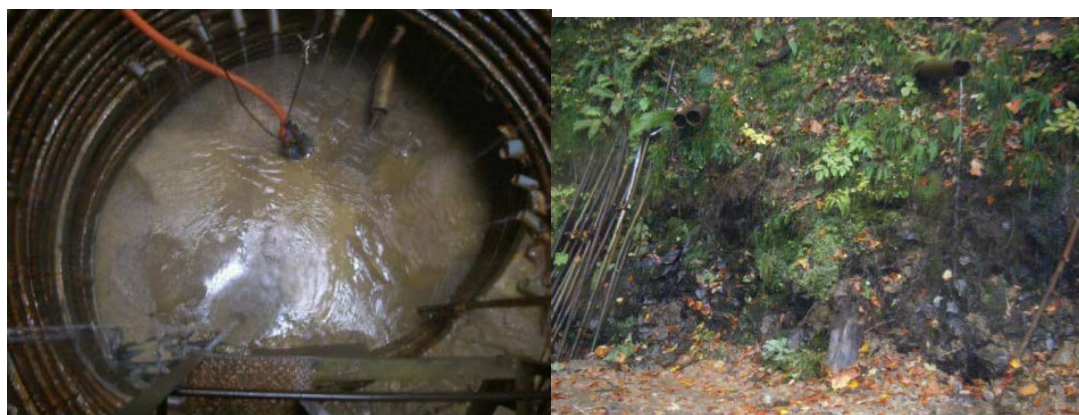
《對策實施前》（左：集水井內情形、右：排水管（出口）情形）
