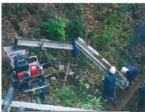
〈堆積土砂撤除情形 2〉
