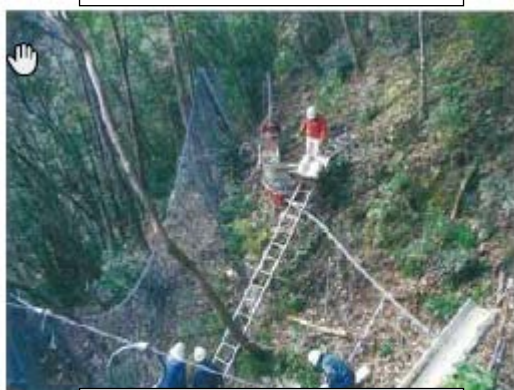
〈堆積土砂撤除情形 5〉
