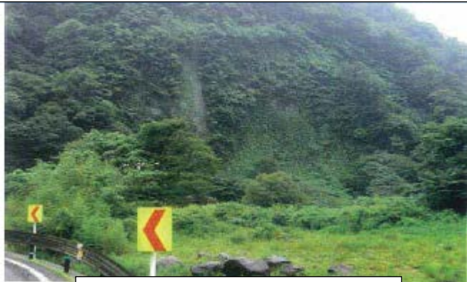
《對策實施前（損傷情況）》
