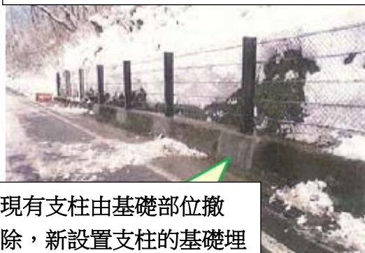
更換落石防護欄及鐵網
