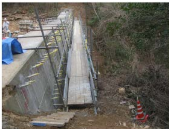
自動低壓注入法 (NETIS 編號 CG-110017-A) 低壓注入藥劑 (40%亞硝酸鋰水溶液+超細微粒注入劑) 《施工狀況》
