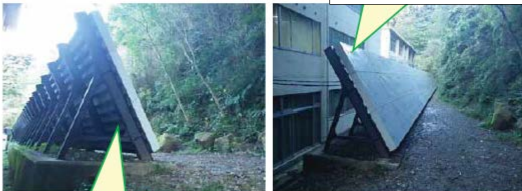
更換鋼材並重新塗裝
