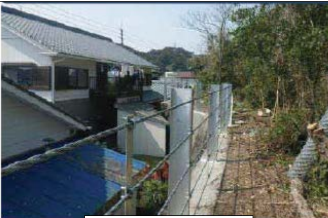
〈防護欄設置情形〉
