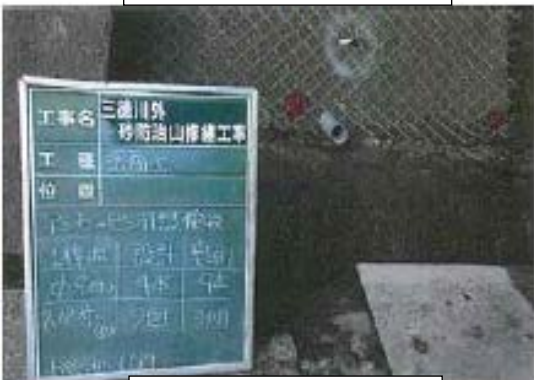
〈錨釘打設驗收〉
