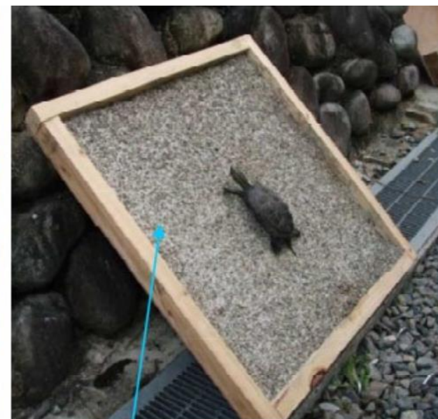
適當的材質與坡面坡度，生物能在此移動，發揮生物棲息與生長場所的機能。
