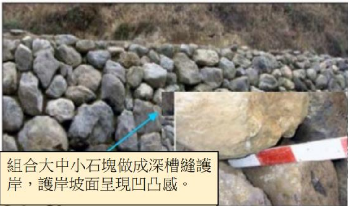
透空塊石疊砌護岸，來自背後的滲透水，可讓坡面保持適當的濕潤狀態。
