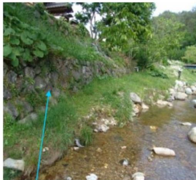
透空塊石疊砌護岸，來自背後的滲透水，可讓坡面保持適當的濕潤狀態。
