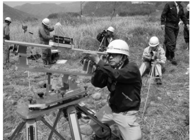
照片參－6 角度計量測實況
