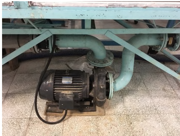
圖 4-5 離心式抽水泵浦
