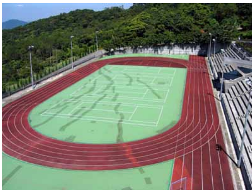
圖 2-12 華梵大學校園西部可能的滑動塊體之地表破裂
