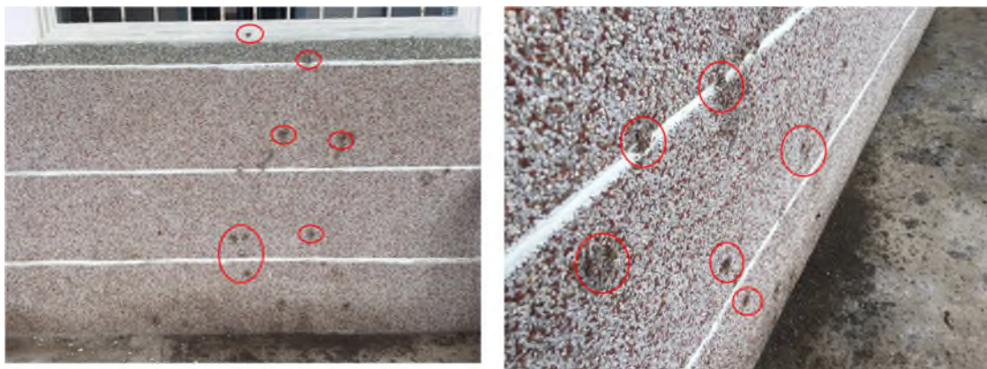
圖 5-17 垂直牆壁之噴植結果
