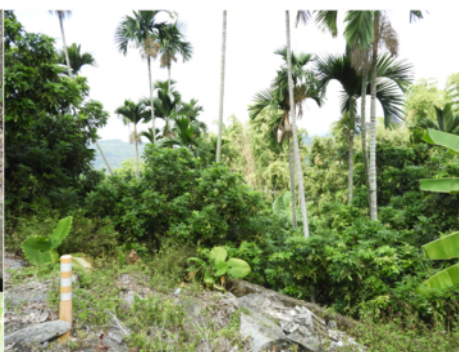
6.道路與護坡工程之間隙 (E=207572.92, N=2598797.72)
