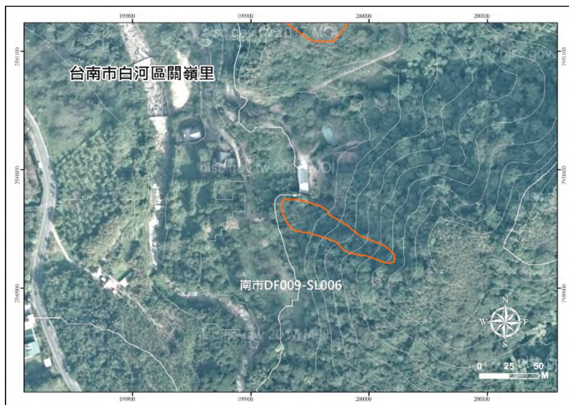
圖4-7 台南市白河區關嶺里淺層崩塌(編號：南市 DF009-SL006)
