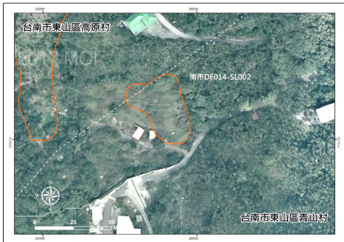
圖4-9 台南市東山區青山村淺層崩塌(編號：南市 DF014-SL002)
