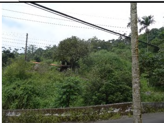
照片 1 坡面上長滿植被，崩塌下面有電線桿經過。
