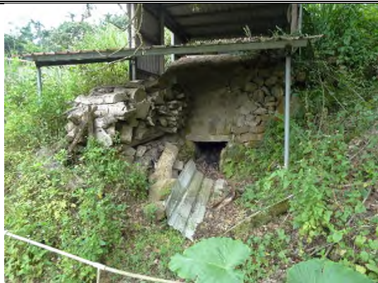
照片 3 邊坡底下有窯以及農舍。
