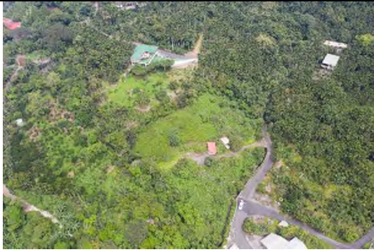
照片 5 由無人機可看出崩塌下方緊鄰河道，而崩塌上方有民宿。
