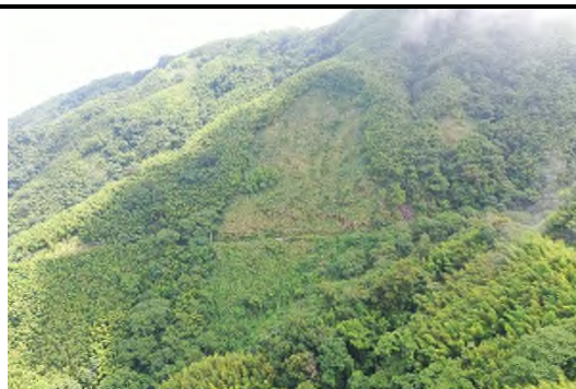
照片 4 邊坡的整體空拍照，可看出道路旁的下邊坡也有舊崩塌地痕跡。
