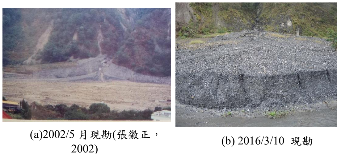
圖 5-25 農富橋上游陳有蘭溪右岸野溪土石流堆積扇
