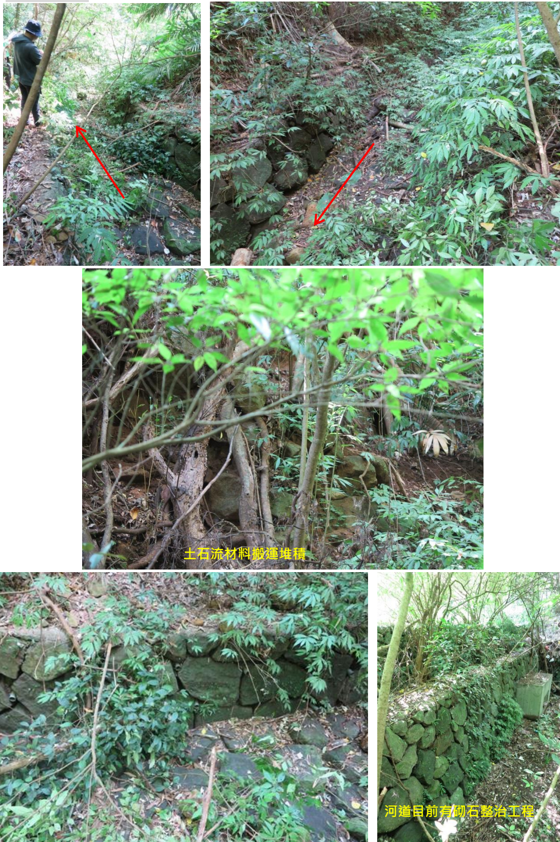
圖 5-7 A 研究區內坡面型土石流河道及土石流材料搬運堆積現況
