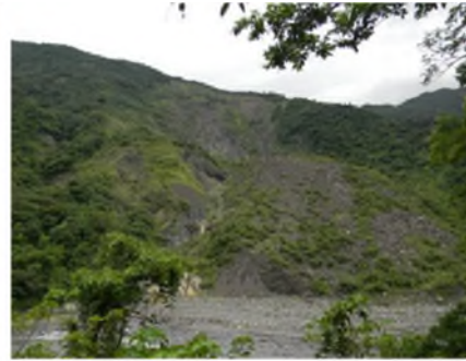
E. 內社聚落上游右岸之河岸邊坡受河流轉彎攻擊侵蝕崩塌情形，已堆積大量崩塌土體。
