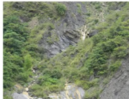
C. 編號A位置近拍，裸露岩層邊坡發現岩層剪裂錯動痕跡，岩層局部有擾動及破碎情形。
