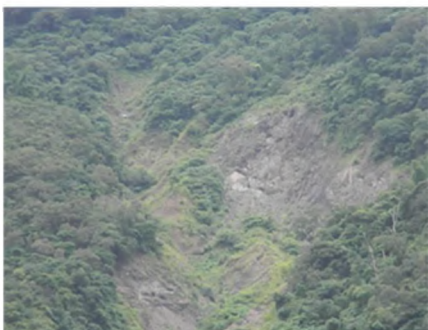
D. 裸露岩層邊坡上方已出現明顯向源侵蝕溝。
