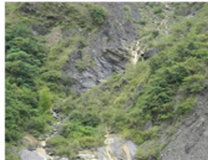
F. 編號E崩塌土體下游測出現明顯向源侵蝕溝。
