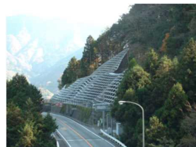
坡面崩塌防止對策
