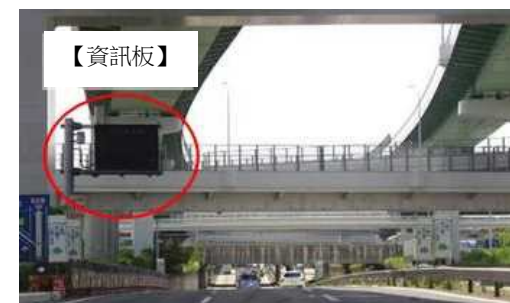
道路覆水對策（資訊板）
