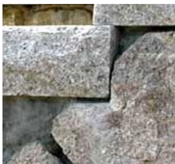
石塊切割痕跡外露，非塊石疊砌風格
