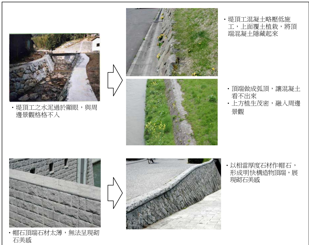
圖-3-5 砌石構造物頂端美化做法
