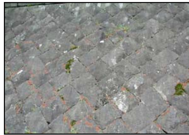
以切割石材疊砌之河川護岸 （四角石材、斜交疊砌）（秋田縣橫手川）
