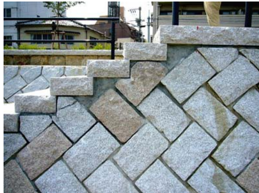
圖-3-7 欠缺美觀的隅角處理案例
