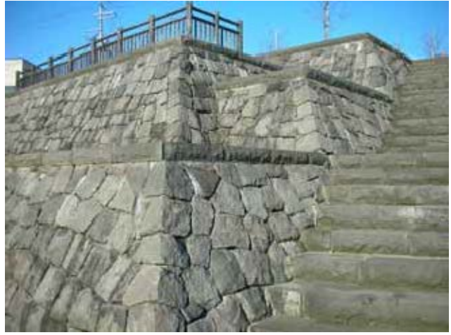
秋田縣橫手川 1998年左右完工 頂面與階梯銜接部分收束良好
