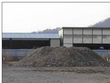
以市管理用地作為石料場 (岐阜市 基地整備部)
