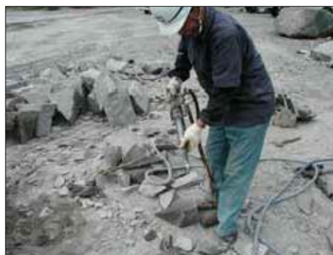
四角石材與雜切割石加工狀況 需一塊一塊加工，相當費時
