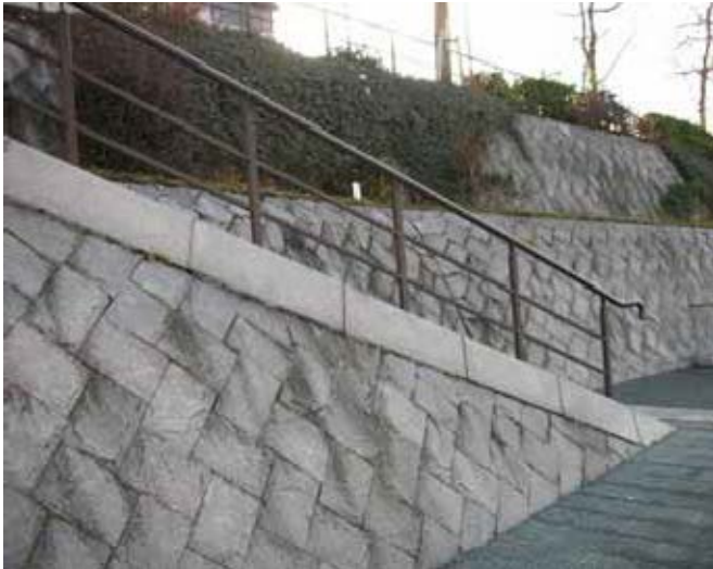
京都府鴨川 1998年左右完工 與階梯銜接部分頂端帽石處理，乾淨俐落有設計感
