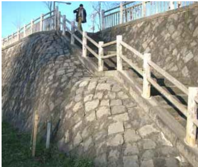
秋田縣橫手川 1998 年左右完工 護岸與階梯銜接採弧頂處理
