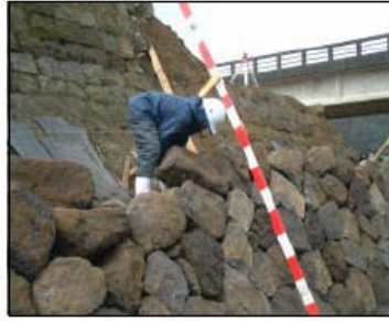
照片-3-1 人力施工
