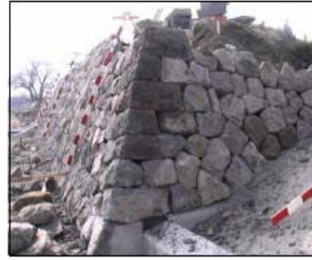
照片-3-2 隅角部實施算木積處理
