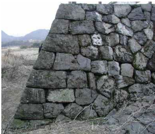
熊本縣綠川 2005年左右完工 頂端「算木積」處理妥當
