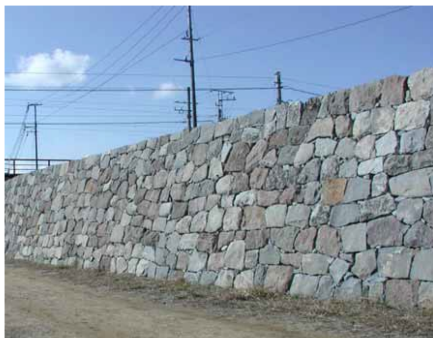
熊本縣綠川（國土交通省 熊本河川國道事務所）河川工程留下護岸石材，目前正搭配新石材重新利用
