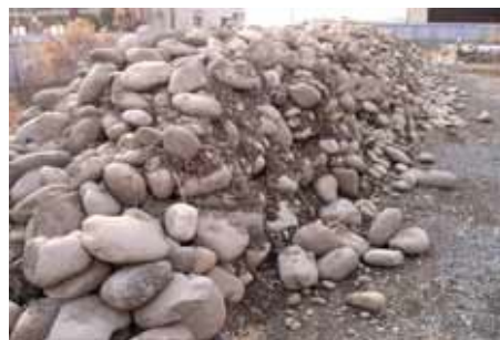
拆除舊護岸所產生的石材，可重新利用。
