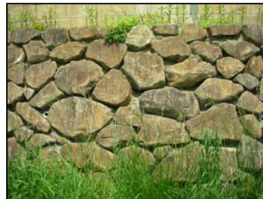
挖出之石材堆積而成河川護岸 （粗石（大卵石）、隨意疊砌）（宮城縣廣瀨川）
