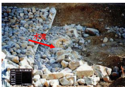
照片-1-8 固床工全景
