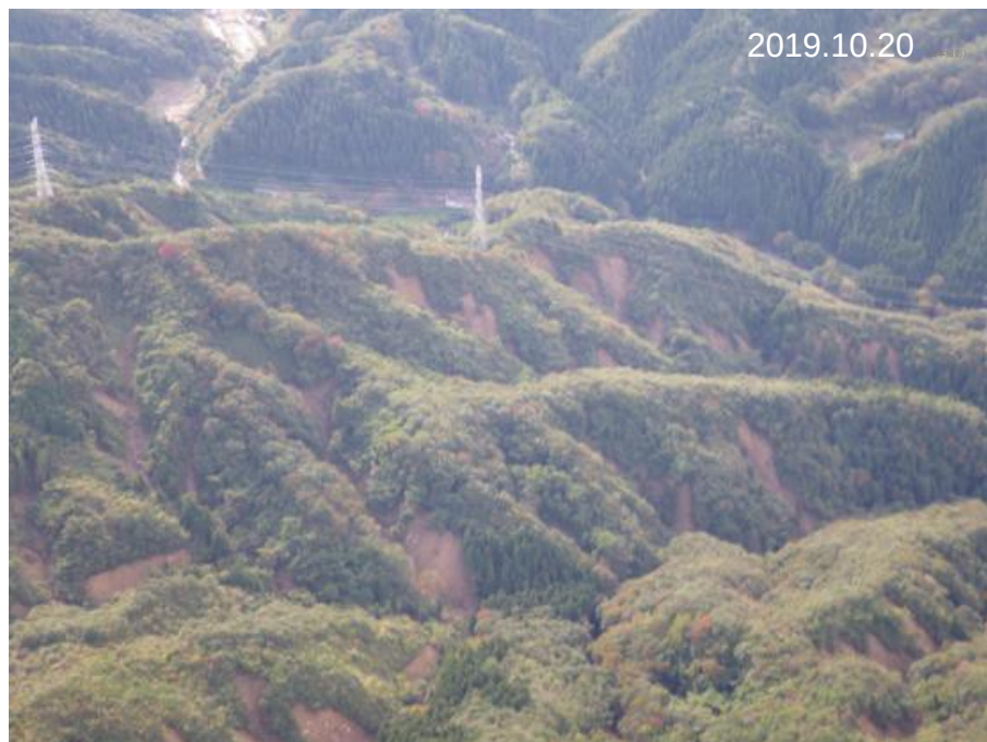
以向東坡面為主，發生許多表層崩塌（五福谷川）
