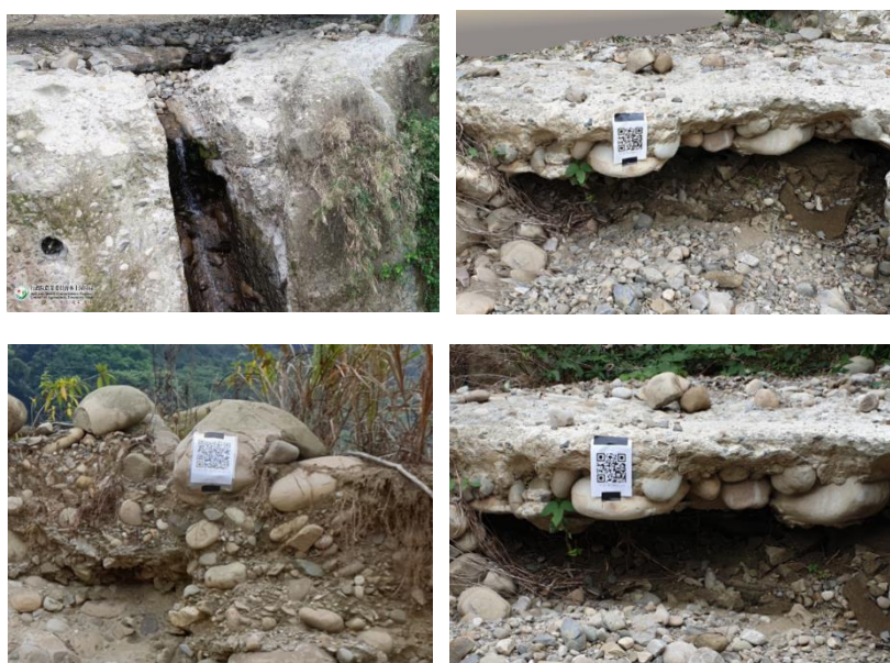
圖十四 大湖口溪建模—砌石損壞狀況（左上）、壩體基礎刷處建模（右上）、QR 碼輔助特徵點設置（左下、右下）。
