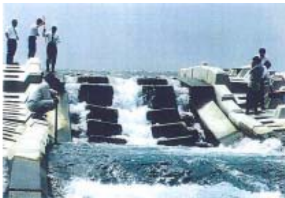
＜魚道下半段淘沙緊急對策工案例＞
