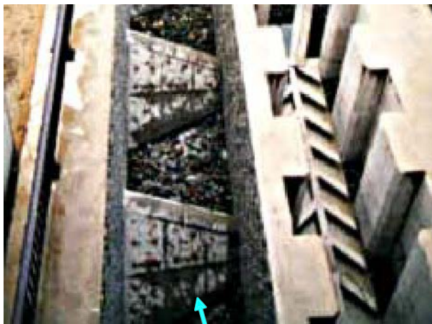
傾斜隔壁式階梯魚道
