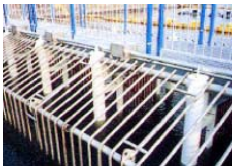
電子防護柵：以電子屏障防止魚類侵入
