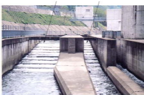
上游側魚道隔壁也採可傾倒式
