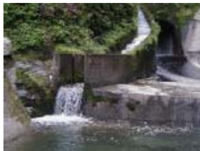
＜魚道下游段河床降低的魚道＞
