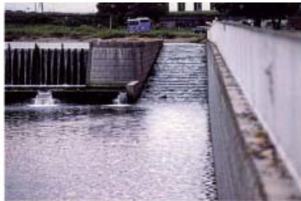
上溯魚不易發現魚道下游端，設置副壩、協助魚類由魚道下游端游向上游側的魚道案例
