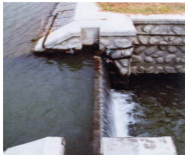
魚道上游端去角以調節魚道流量
