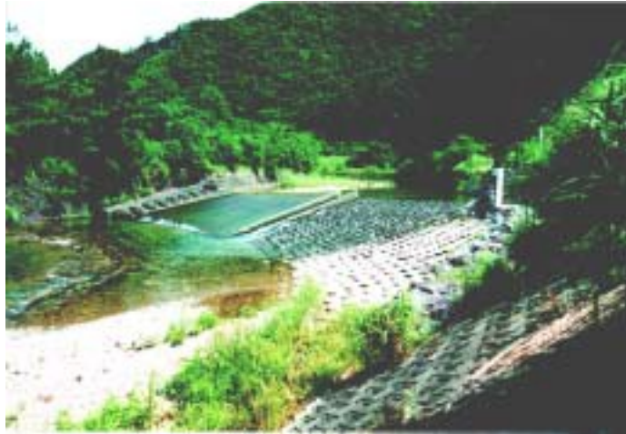
川内川魚道設置案例
