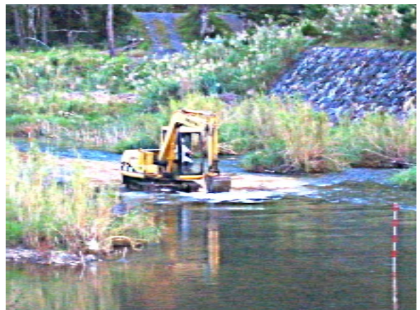
以挖土機整理河床
