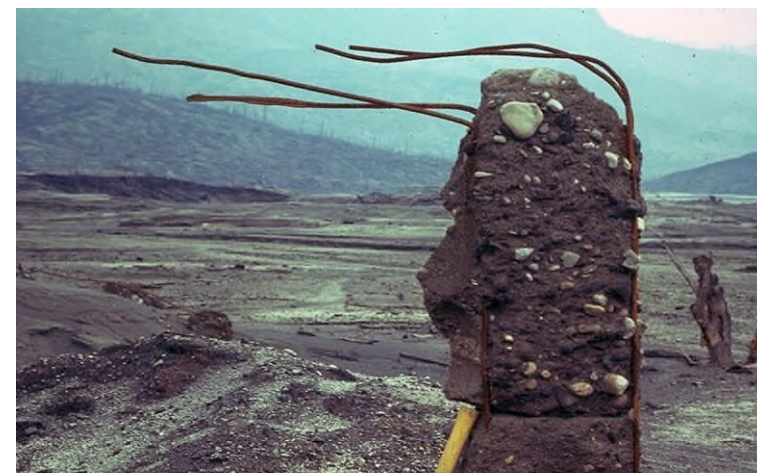
1982年墨西哥El Chichon火山爆發，圖為被火山碎屑流和水流破壞的建築物殘骸，混凝土中的鋼筋甚至也沿流動方向彎曲。
