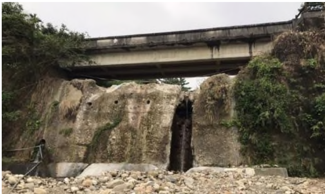
圖 4-39 第三號防砂壩(現地照片 1)
