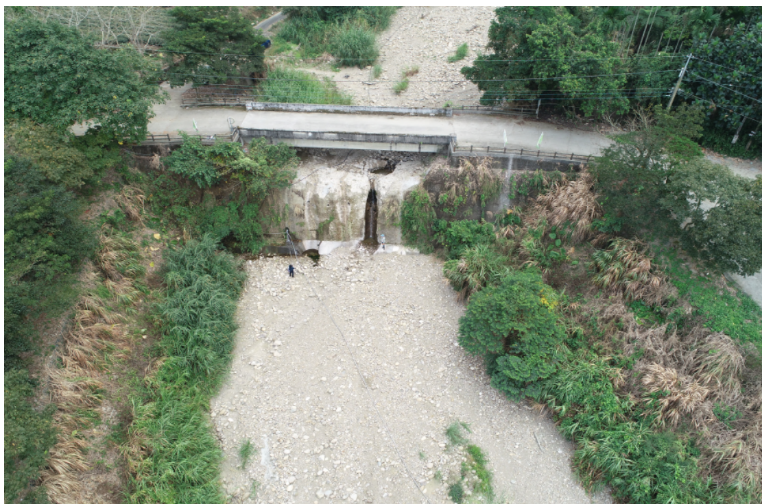
圖 4-40 第三號防砂壩(現地照片 2)
