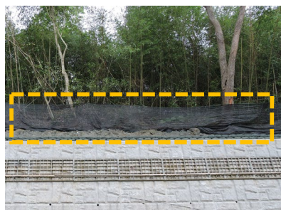
竹林與工區之間拉設黑紗布，將野生動物棲地及工區隔離，降低工程施作對生物之影響。
