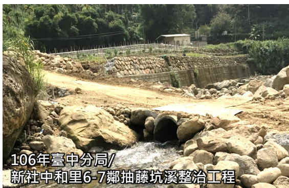
機具過溪床處 鋪設涵管
