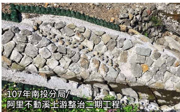
護岸設置粗糙斜坡式動物通道
