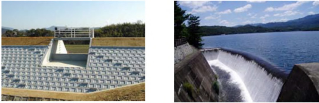
圖 2-3 溢洪道排放口 (農林水產省，2015)
