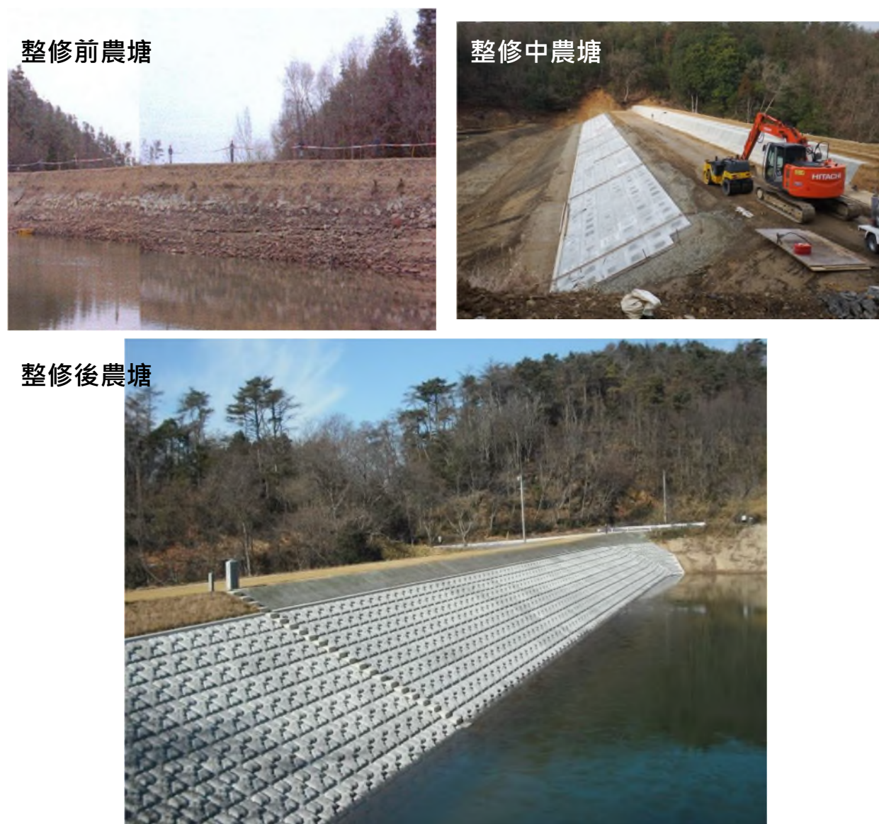
圖 2-5 農塘堤體塊石護坡 (農林水產局，廣島縣，2019)
