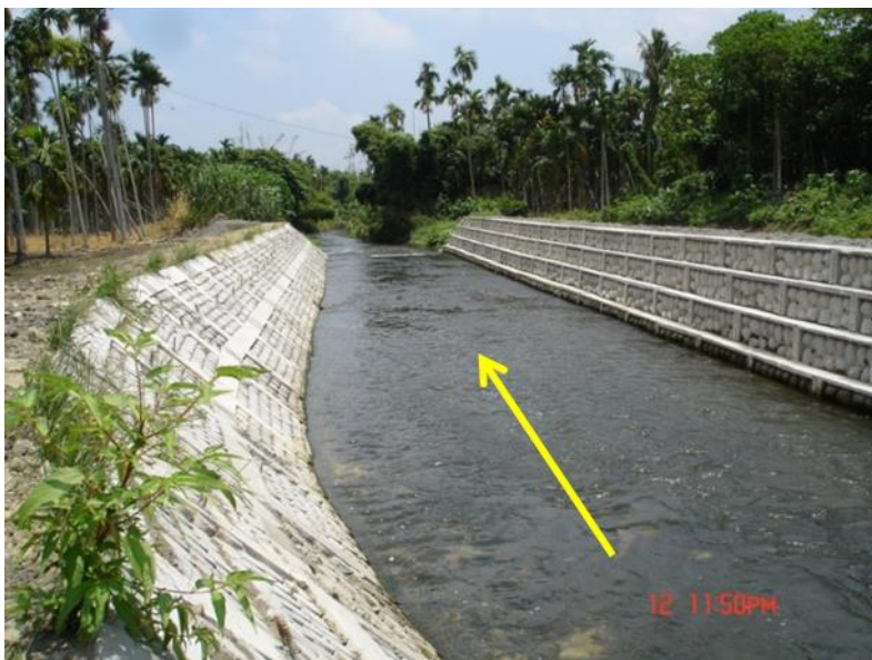
圖 3-9 平面鋪席型(左岸)與分層疊砌型(右岸)預鑄護岸
