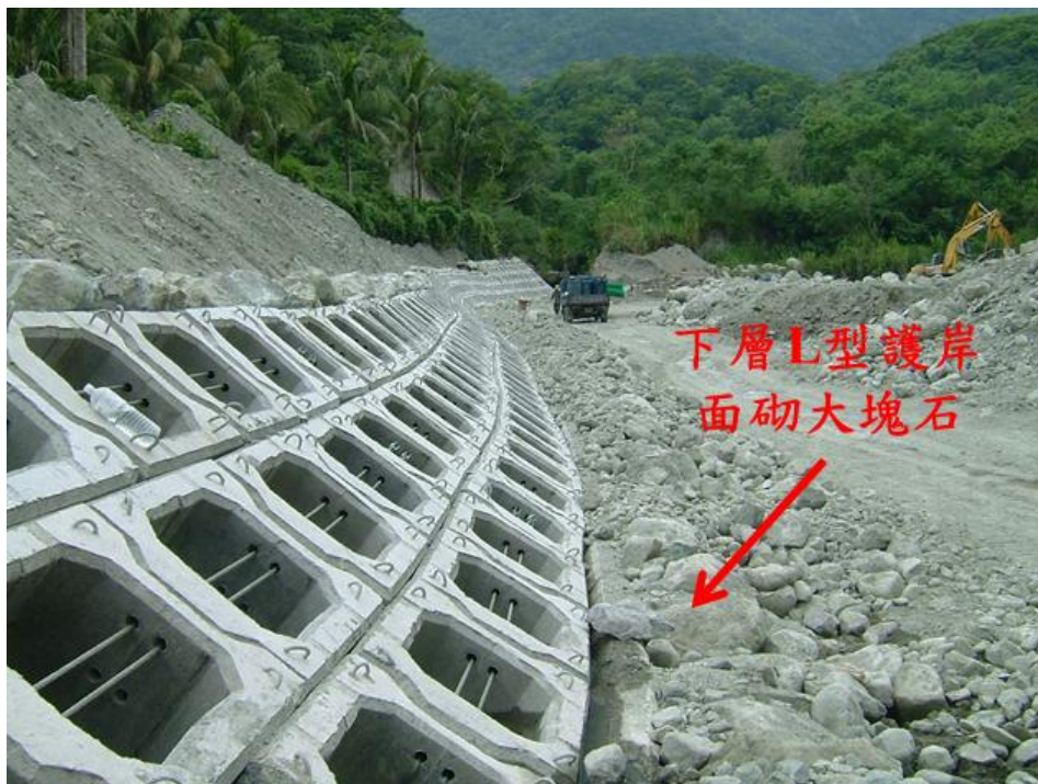
(a) 施工中低水位護岸
