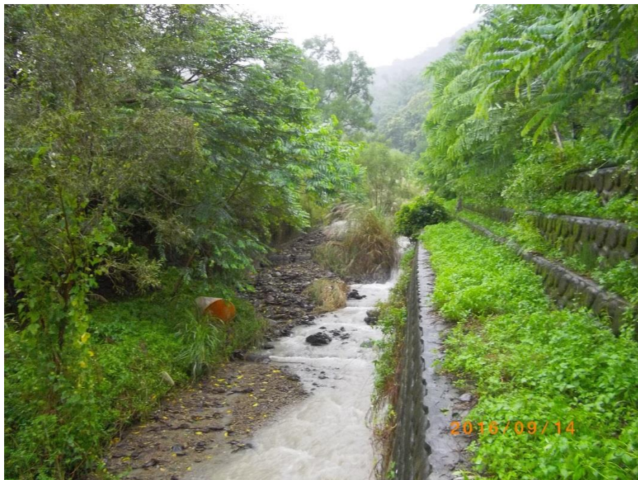
(b)竣工後5年之現況
