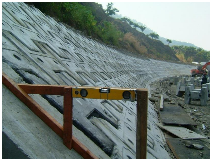
照片 6 護岸坡度檢驗
