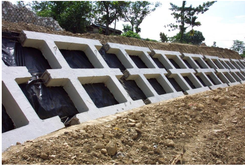
圖 3-4 預鑄護岸土工織物濾層
