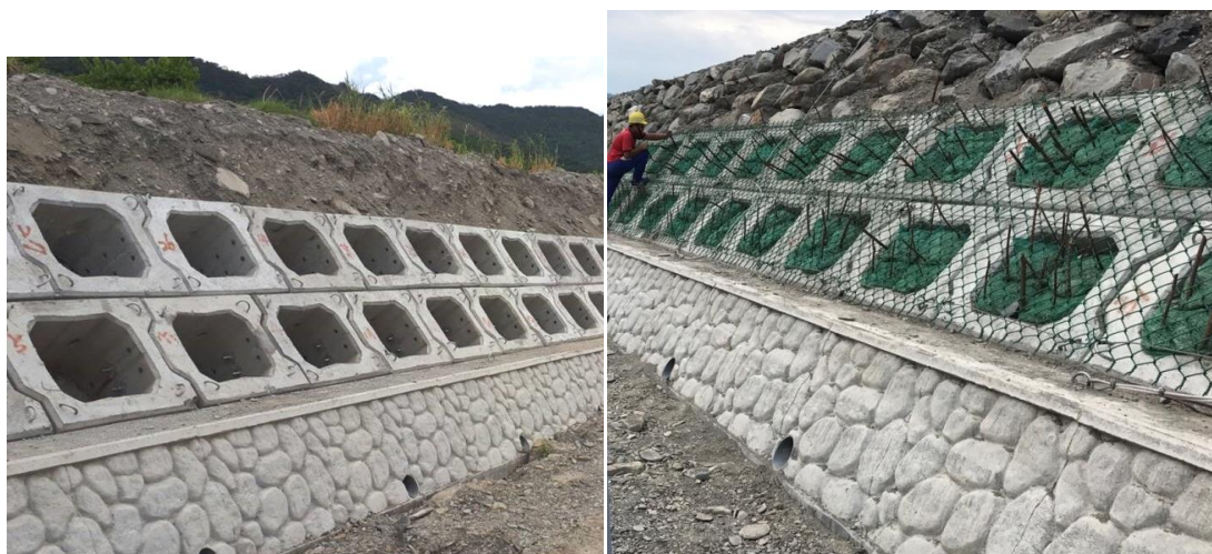
照片 14 鋪設 RC 箱塊
