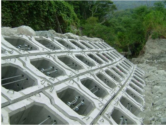
(a)羊橋四期整溪整治工程
