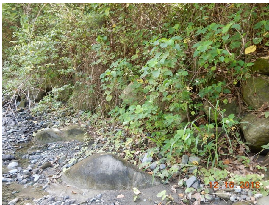
照片 5-9 低水護岸穩定現況
