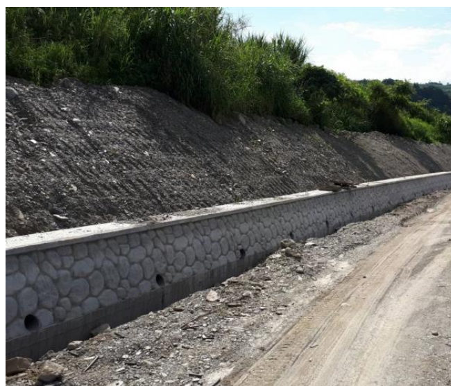
照片 13 護岸整坡
