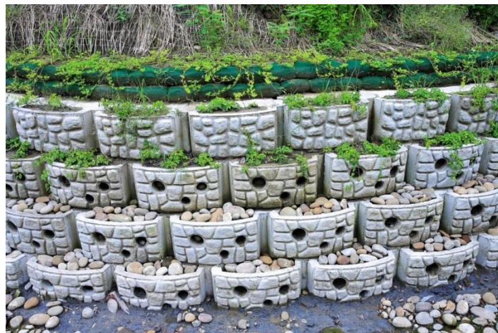
照片 10 完工照片
