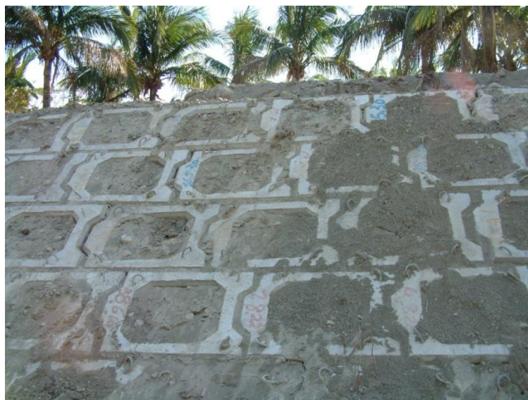
照片 5-6 RC 箱回填土壤
