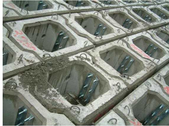
(b)羊橋三橋野溪整治工程
