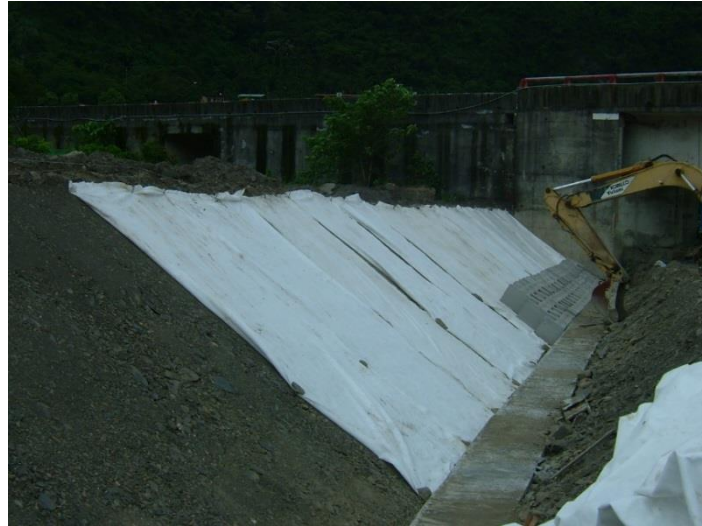
照片 3 鋪設濾層
