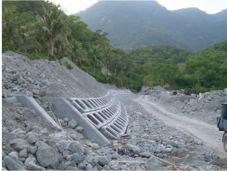
照片 5-5 護岸隔牆
