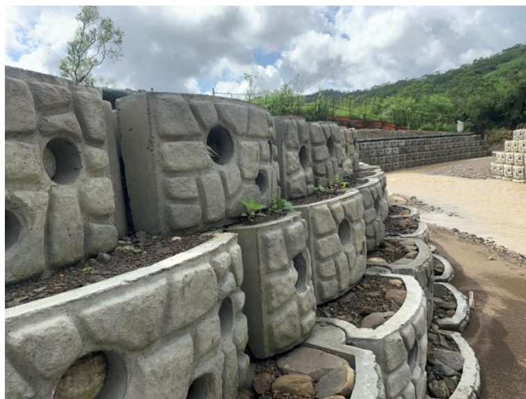
圖 3-7 預鑄塊內回填土方及卵礫石
