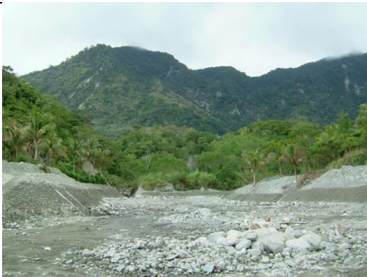
竣工後RC箱坡面回填溪床礫石料 後扦插原生種蘭嶼鐵莧竣工
