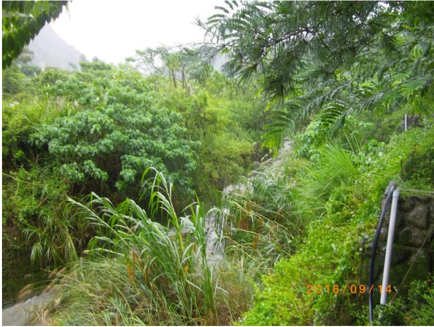
照片 5-14 護岸穩定現況
