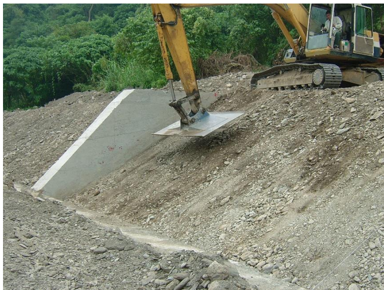
照片 2 溪流岸坡整坡
