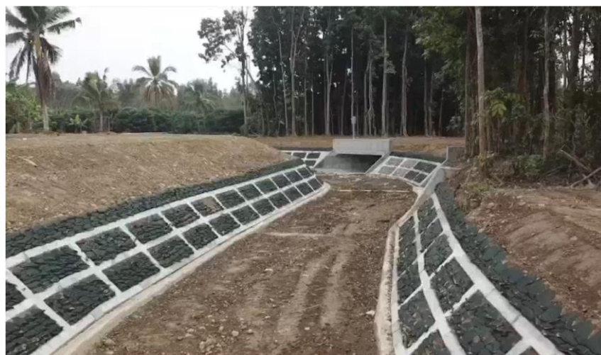
圖 3-3 凹岸處設置系列固床工
