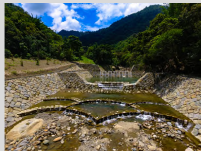
東西坑溪野溪治理七期工程
