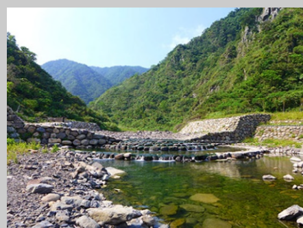
大溪溪鐵路橋上游 治理二期工程
