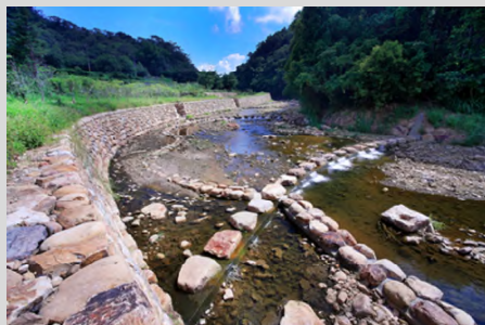
水流東溪4K+380 支流整治工程
