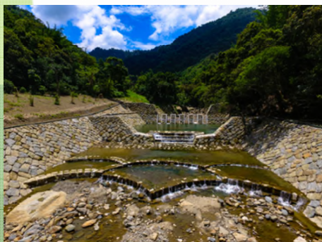
東西坑野溪治理七期工程(GR=32%)
