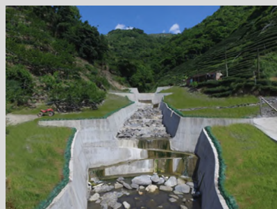
老部落下線排水改善三期工 程
