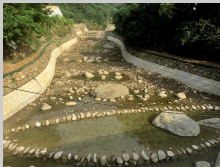
頭汴溪中埔十號橋 上游整治工程
