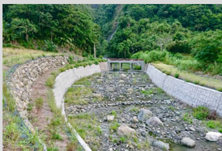
樂哈里哈拉灣溪支流 整治加強工程
