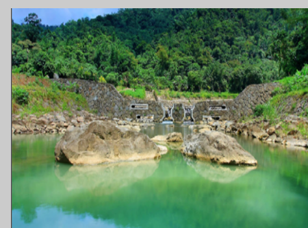
東西坑溪崩場地及野溪 治理五期工程
