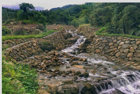
粗坑溪上游野溪 整治工程
